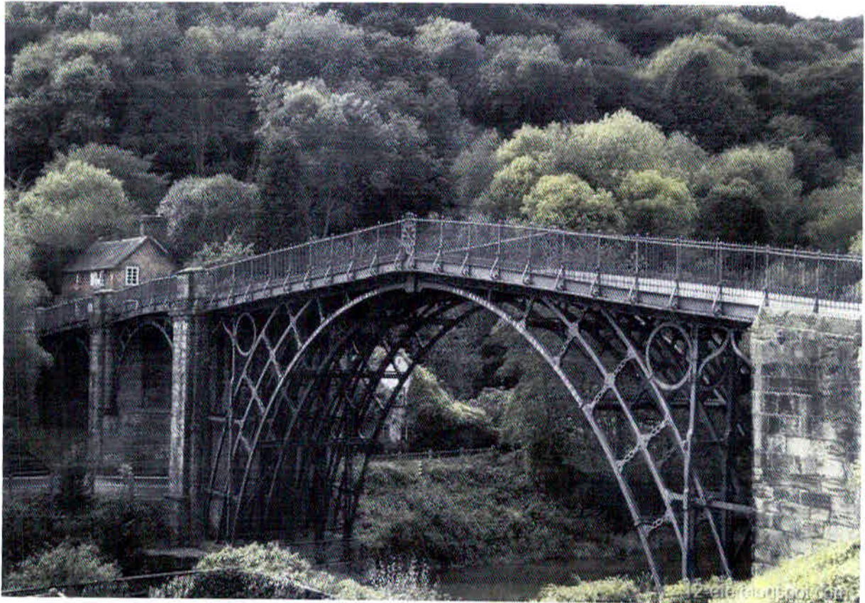
Figura 01: Ponte sobre o rio Serven
