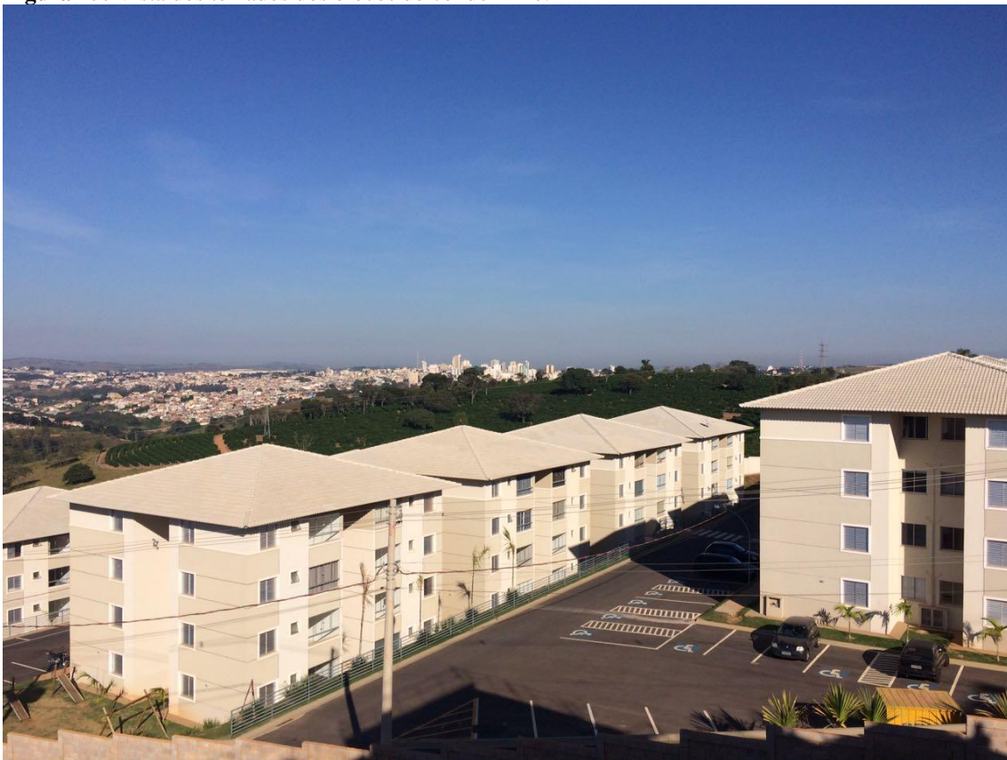
Figura 45: Vista dos telhados dos blocos do condomínio.
