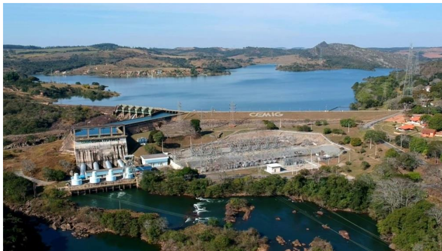
Figura 1: Fotografia aérea da Usina hidrelétrica de Itutinga-MG
