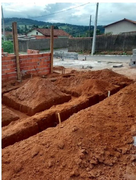
Figura 1 – Canteiro de obra.
