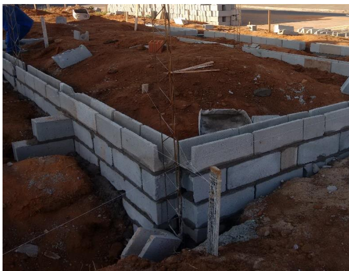
Figura 6 – Proteção das ferragens.
