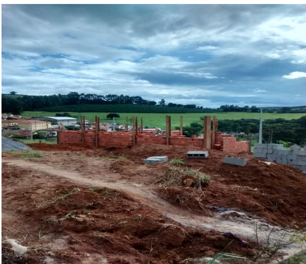
Figura 3 –Destinação de demolição.
