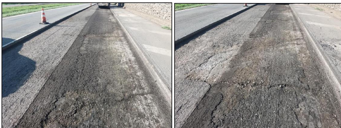
Figura 7 e 8 - Fresagem Funcional de 5cm - Base Trincada
