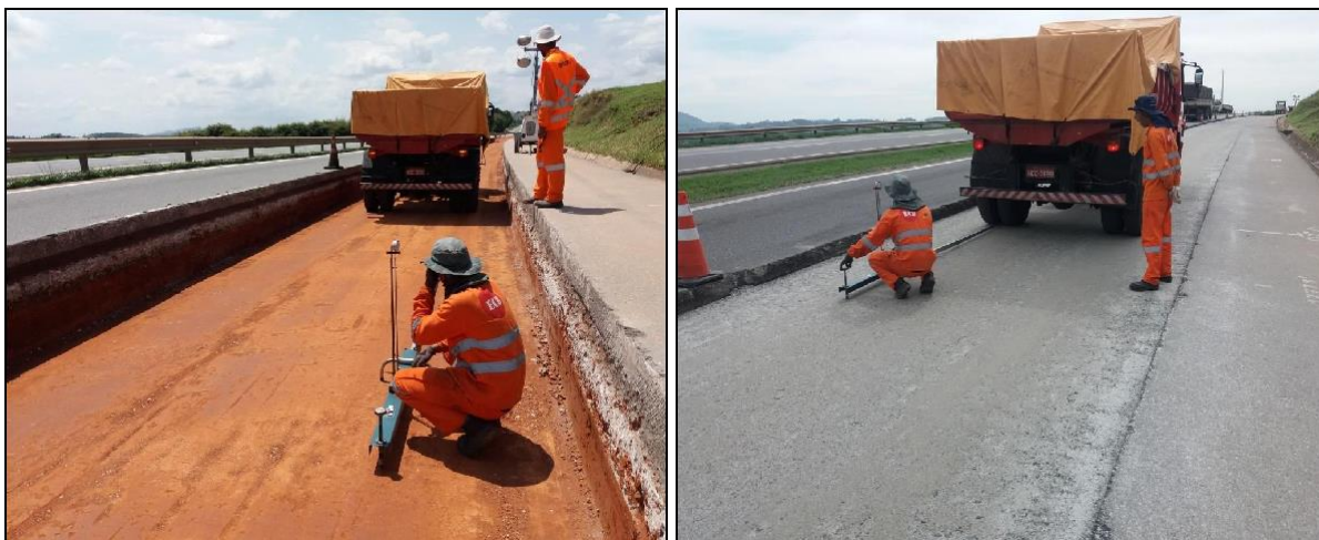
Figura 12 e 13 – Ensaio de Viga de Benkelman
