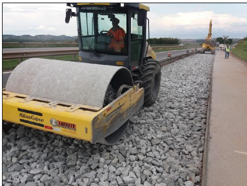
Figura 14 – Aplicação de Macadame
