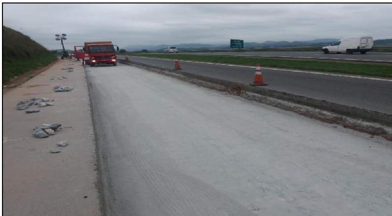
Figura 15 - Aplicação de BGS
