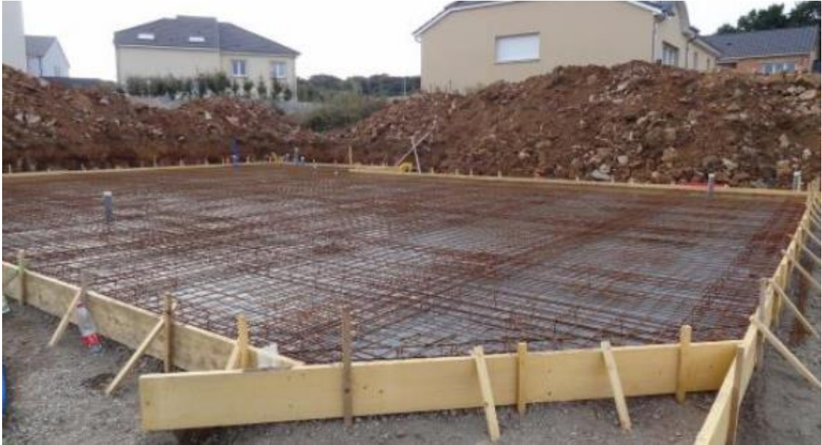
Figura 51 - Radier Armado.
