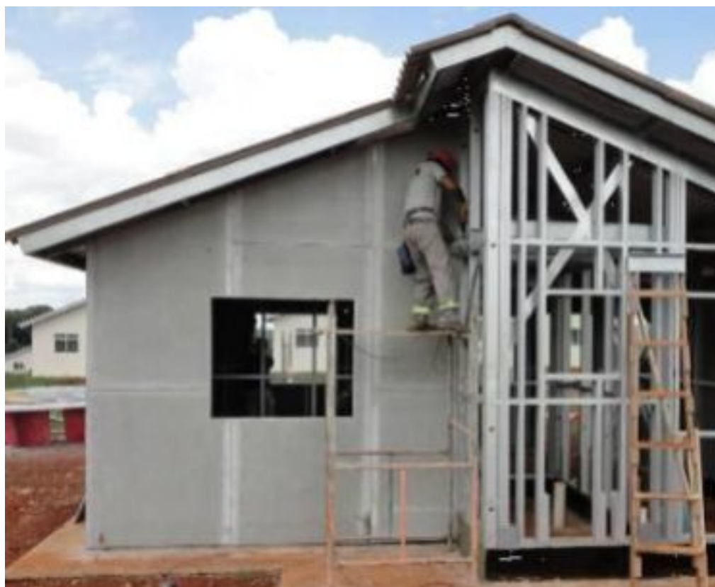
Figura 03 - Construção de Steel Frame
