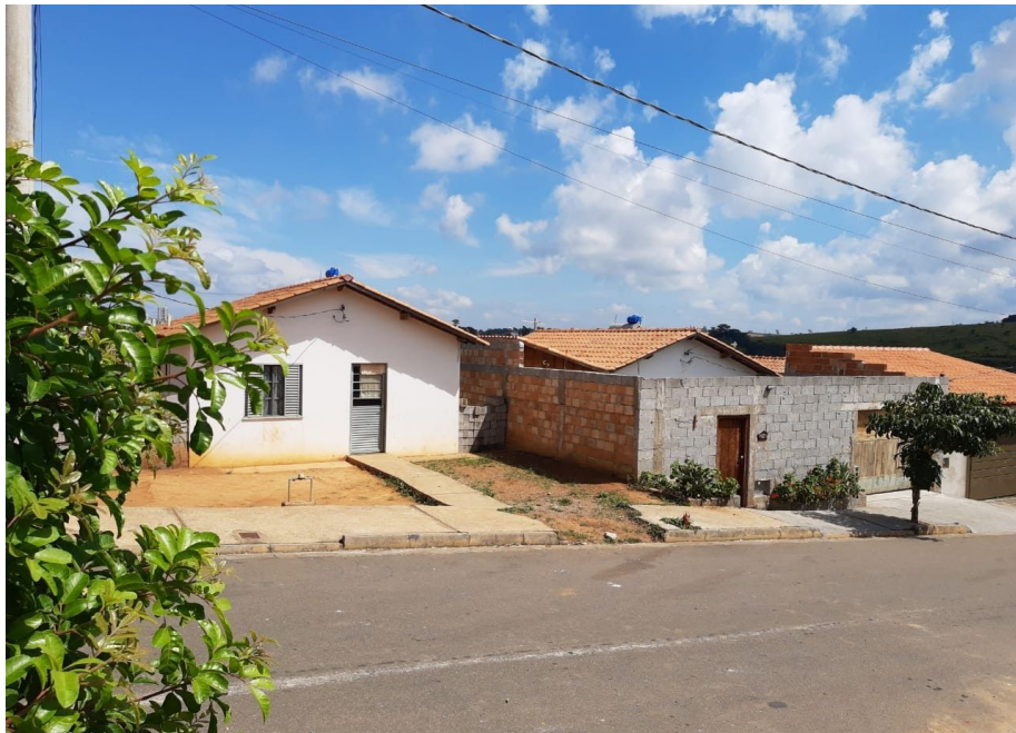
Figura 07 - Casa como projeto original e casa com muro de divisa de lotes
