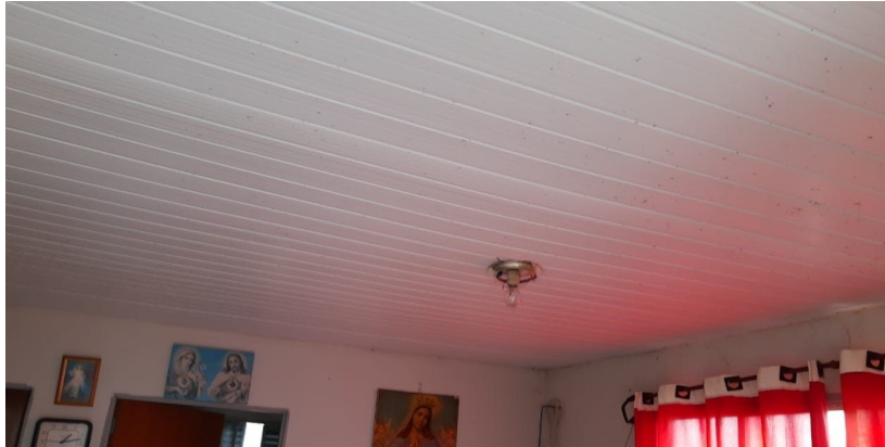
Figura 08 - Teto da edificação
