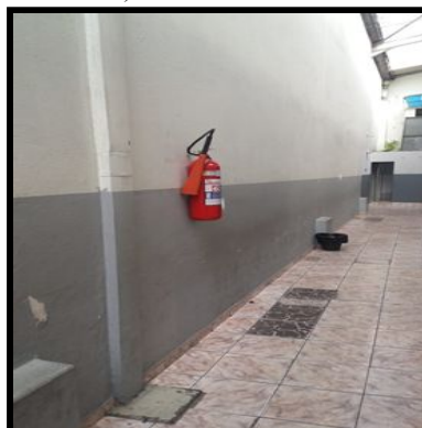
Figura 9: Instalação de iluminação de emergência (corredores)
