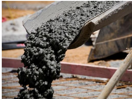
Figura 2 – Produção de concreto
