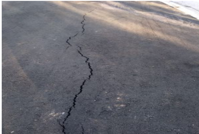
Figura 5: trincas transversais
