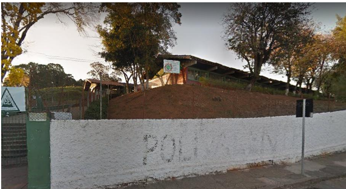
Figura 10 – Fachada principal Colégio Tiradentes.
