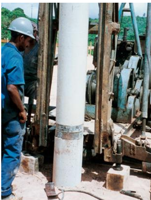
Figura 2.3.2: Emenda das estacas pré-moldadas de concreto
