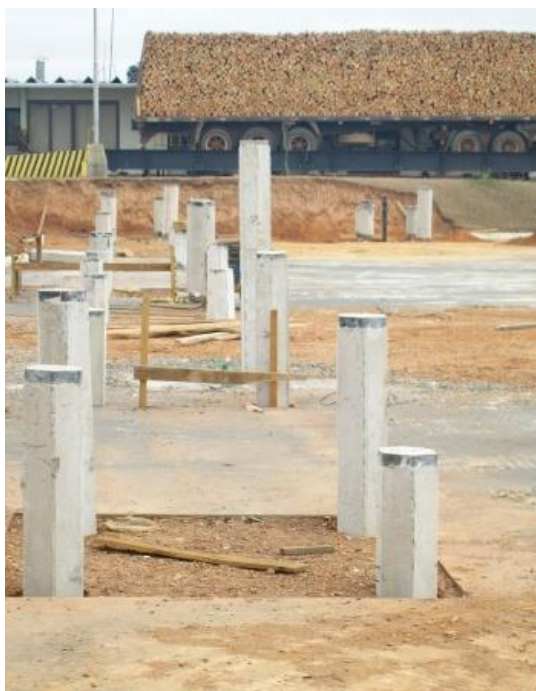
Figura 2.3: Estaca pré-moldada de concreto
