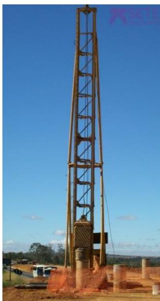
Figura 2.3.3: Cravação das estacas pré-moldadas de concreto
