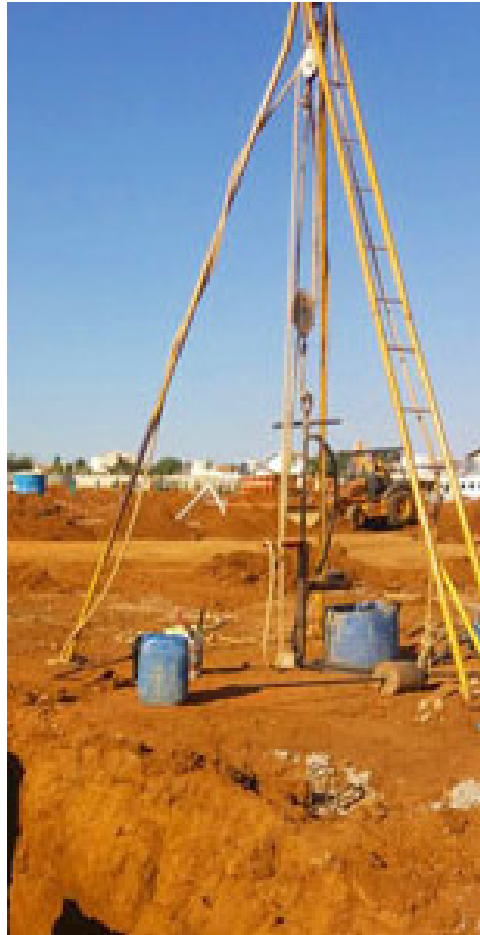
Figura 3.2 : Esquema de perfuração do solo.
