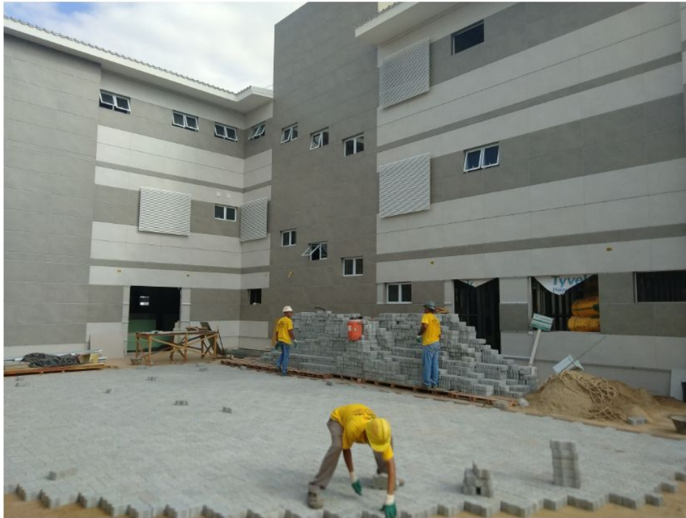
FOTO EXTERNAS - ESQUADRIAS METÁLICAS VISTA LATERAL - UBS CABANA - BELO HORIZONTE
