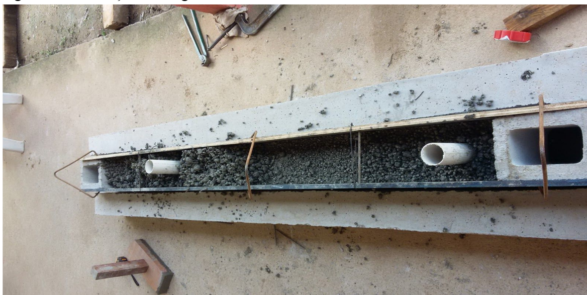
Figura 1 - Fabricação da verga com concreto leve
