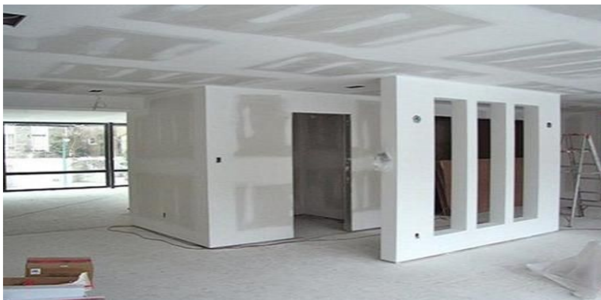
Figura 4 - Placas de gesso acartonado aplicadas
