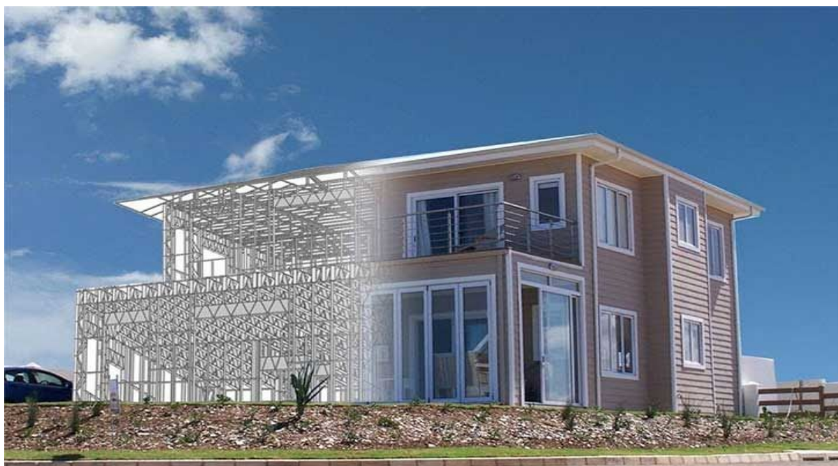
Figura 1 - Construção no sistema Light Steel Framing
