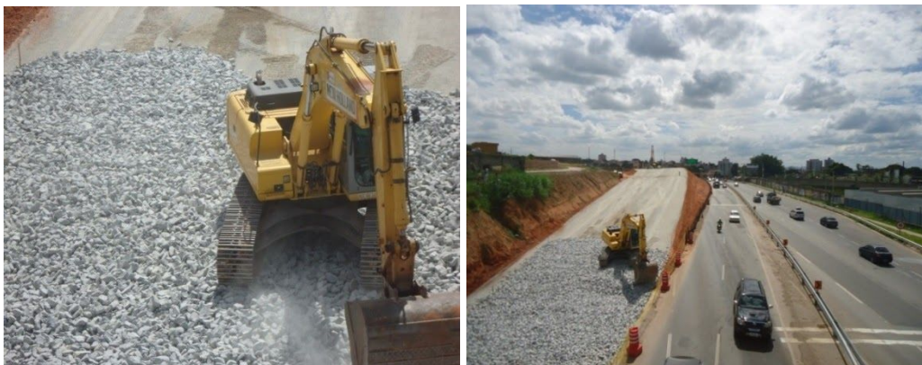
Figuras 15 e 16: Camada de Sub-base “Reforço de Rachão Intertravado”.
