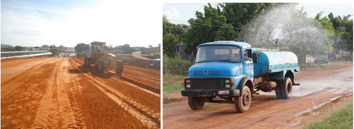
Figuras 8 e 9: Adequação das camadas de aterro e compactação do solo.
