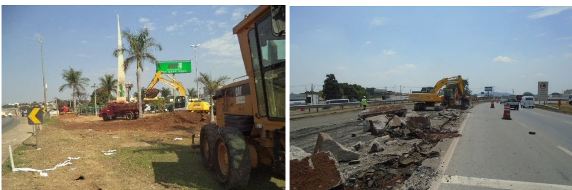
Figuras 6 e 7: Demolição e Remoção dos solos e concreto.
