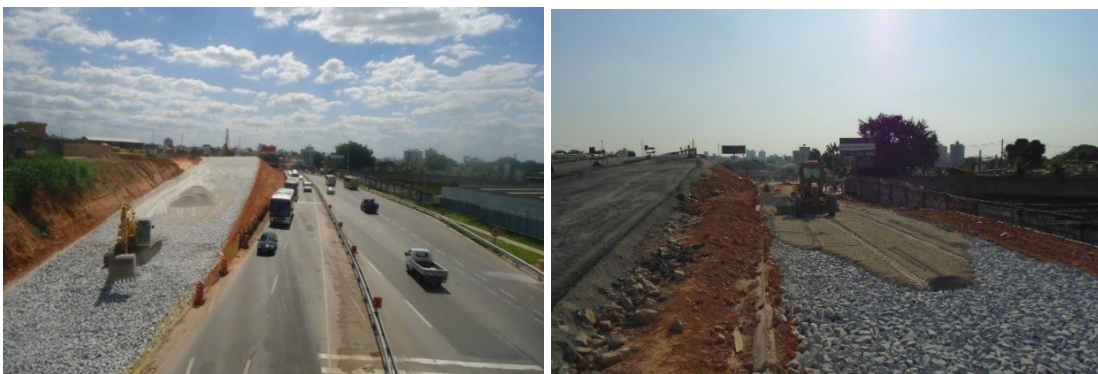
Figuras 17 e 18: Camada de Sub-base BGTC.
