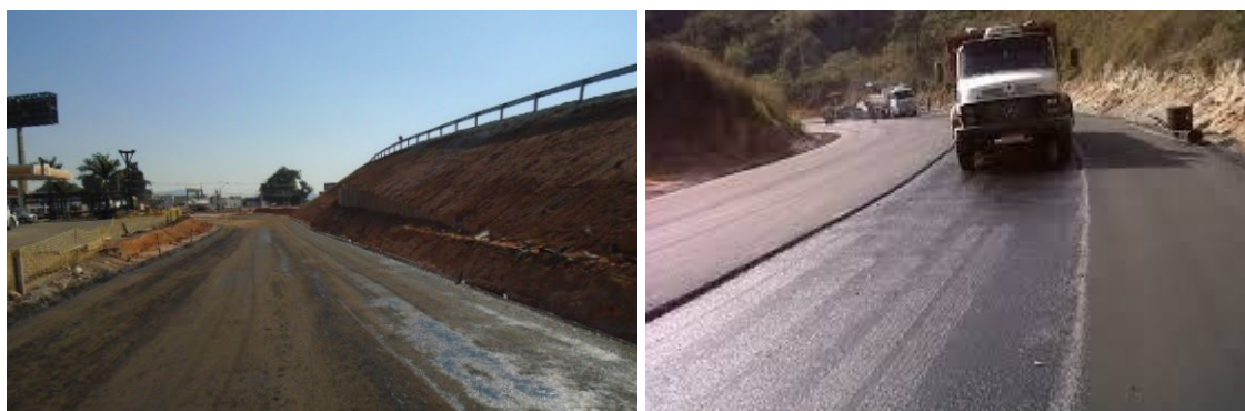
Figuras 21 e 22: Imprimação Asfáltica e Pintura de ligação.
