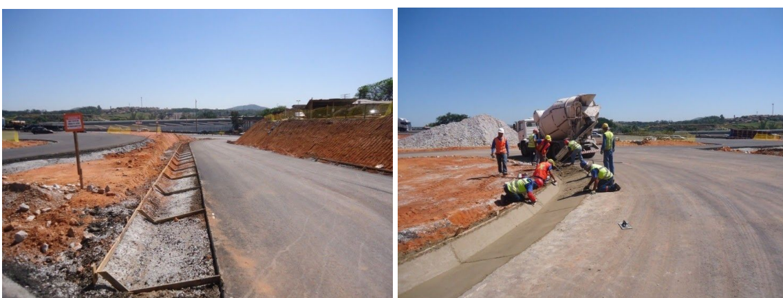
Figuras 25 e 26: Construção e Concretagem da sarjeta, dispositivo de drenagem.
