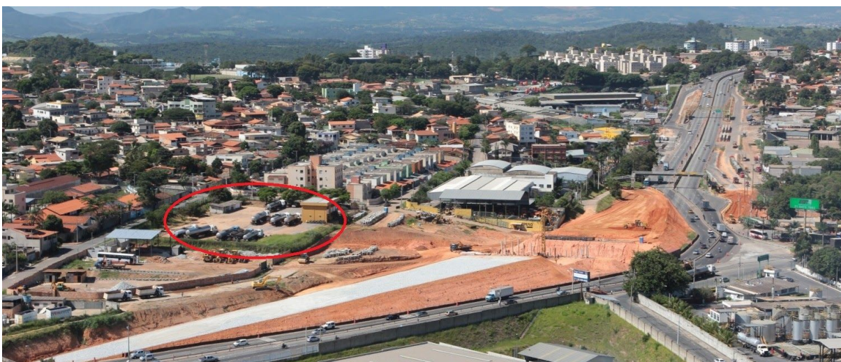
Figura 3: Visão geral do Canteiro de obras
