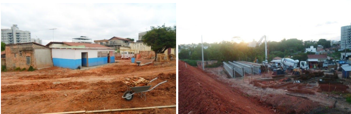
Figuras 4 e 5: Canteiro de apoio para montagem das vigas.
