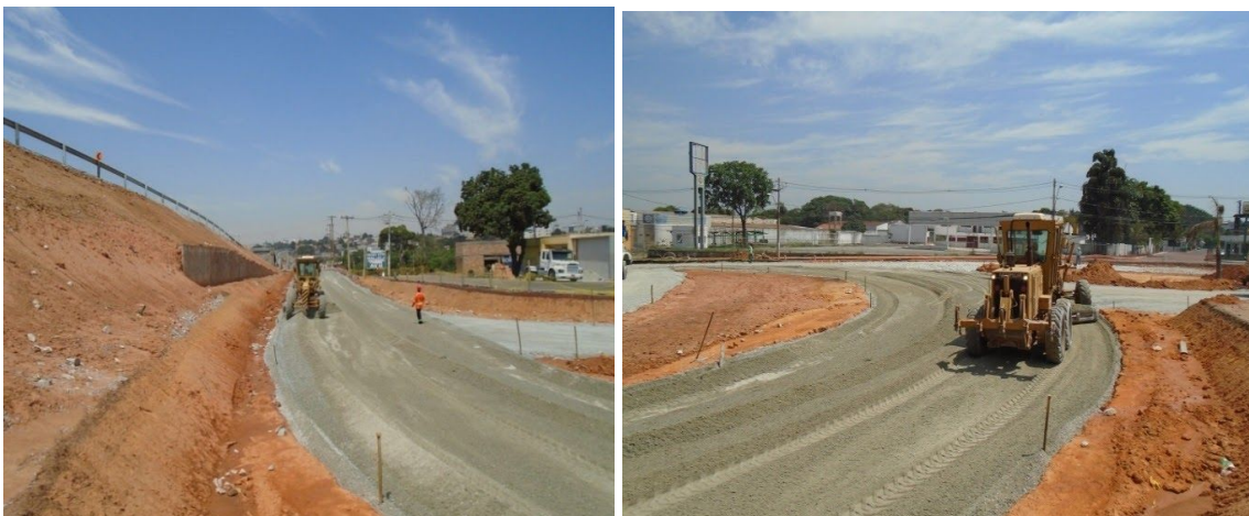
Figuras 19 e 20: Camada de BGS
