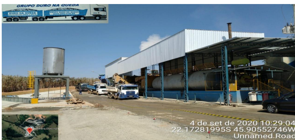
Figura 04 – Usina de Asfalto
