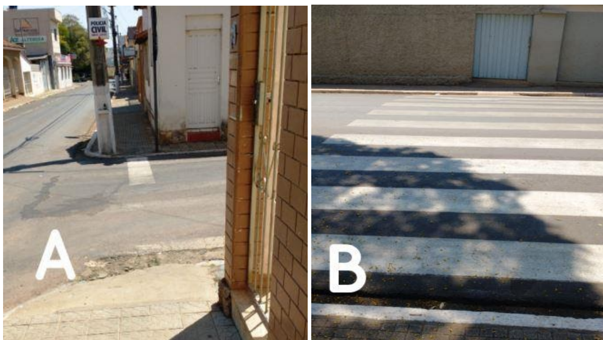
Figura 5: Pontos sem rebaixamento de calçada
