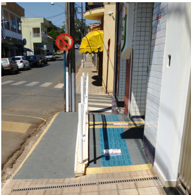
Figura 6: Rampa em local inadequado
