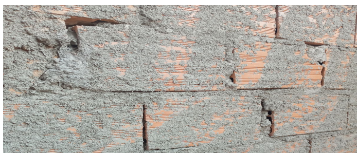
Figura 1 : Chapisco em parede de blocos na residência CG1
