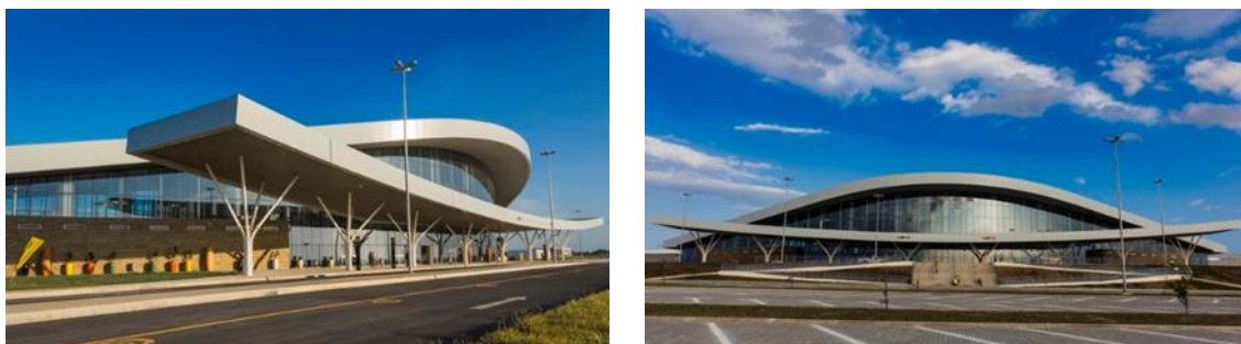
Figura 37: Fachada do Aeroporto Internacional de Nacala
