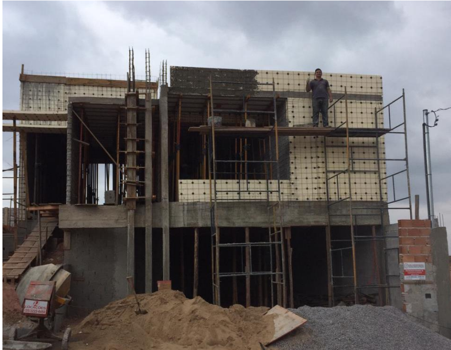
Figura 29: Edificação sendo executada – Varginha/MG.
