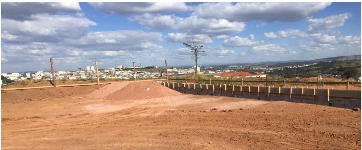
Figura 14: Preparo do solo para receber a fundação – Varginha/MG.
