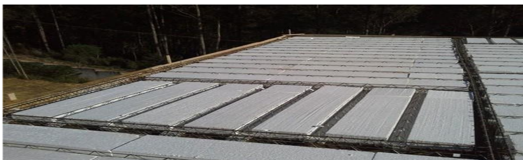
Figura 28: Laje treliçada com preenchimento de isopor.
