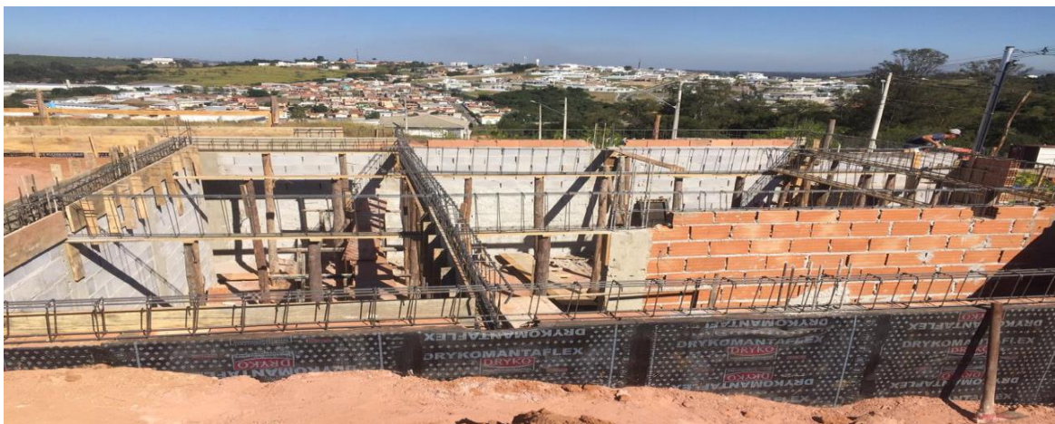
Figura 15: Preparação das vigas para laje de piso – Varginha/MG
