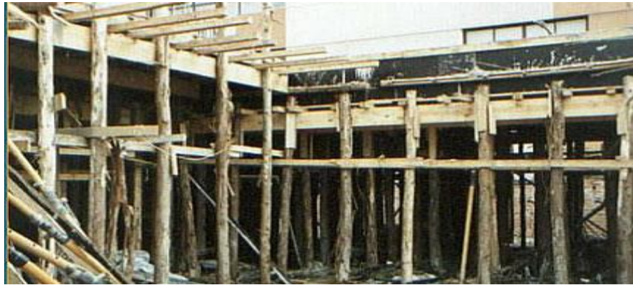
Figura: 39: Cimbramento com Elementos de madeira.
