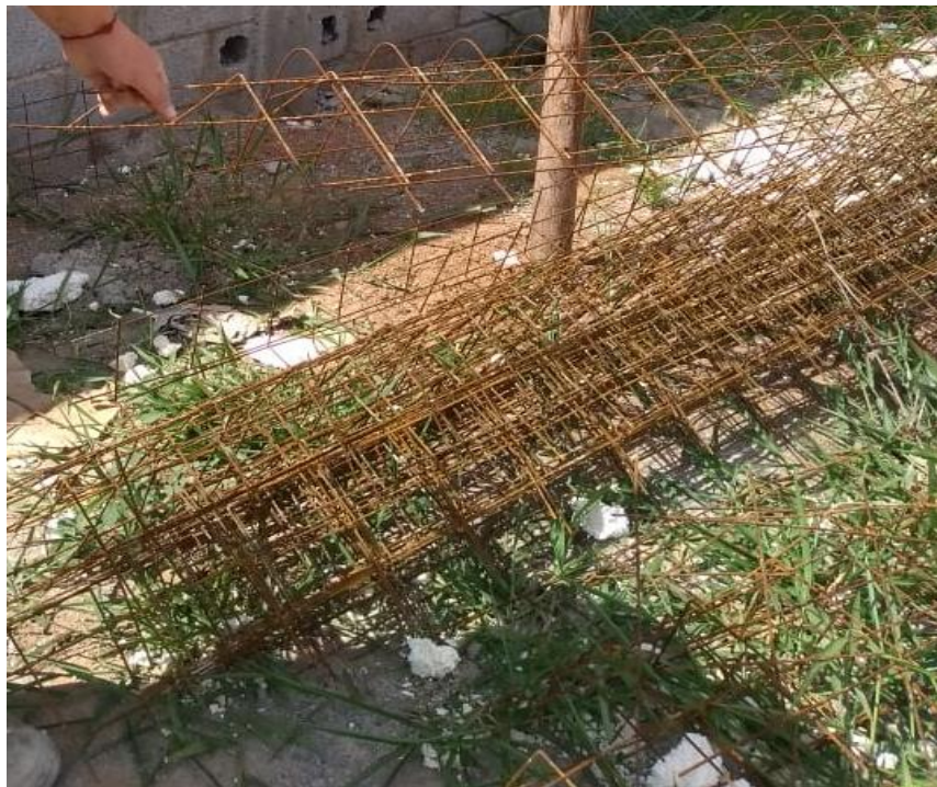
Figura 20: Aço utilizado para reforçar as janelas e colunas
