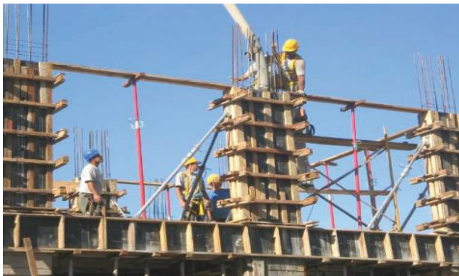
Figura 35: Fôrmas de concreto em compensado plastificado.
