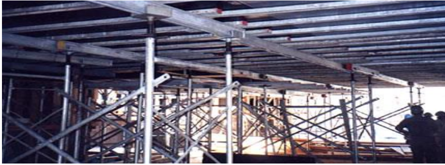
Figura 38: Cimbramento com elementos metálicos.
