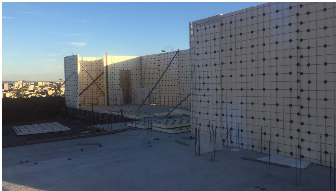
Figura 23: Régulas e escoras diagonais – Varginha/MG
