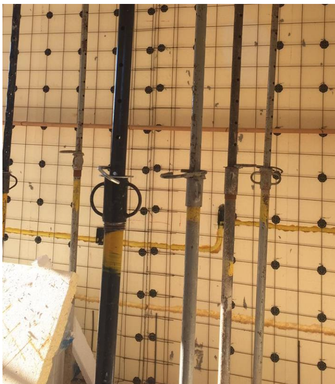
Figura 24: Instalações elétricas e hidráulicas – Varginha/MG
