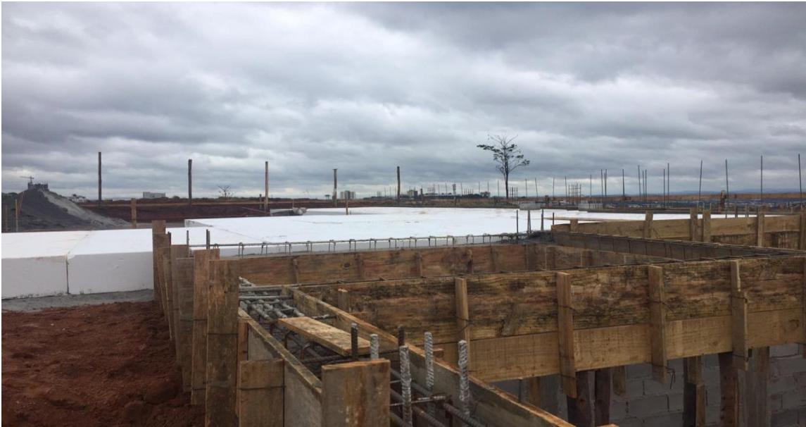
Figura 16: Painéis de EPS sobre a base - Varginha/MG.
