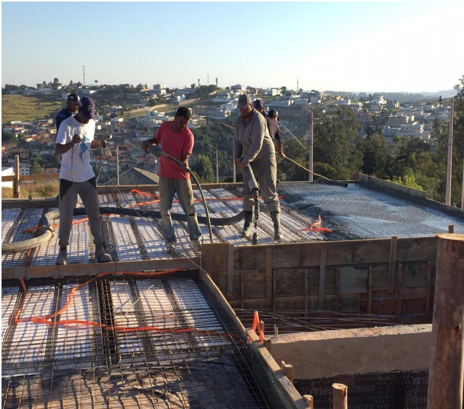
Figura 30: Laje sendo executada – Varginha/MG
