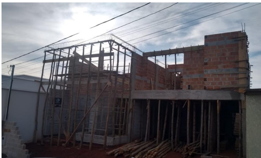
Figura 32: Obra em sistema construtivo de concreto armado – Elói Mendes/MG.
