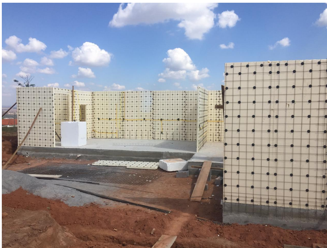
Figura 18: Montagem do sistema – Varginha/MG
