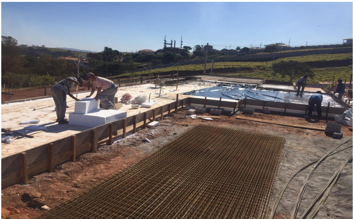
Figura 17: Montagem de radier – Varginha/ MG.
