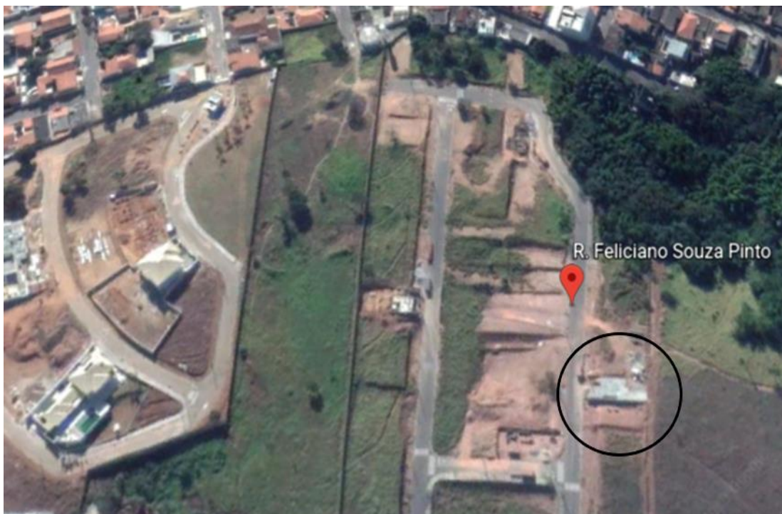
Figura 01: Localização geográfica da obra, Varginha – MG.
