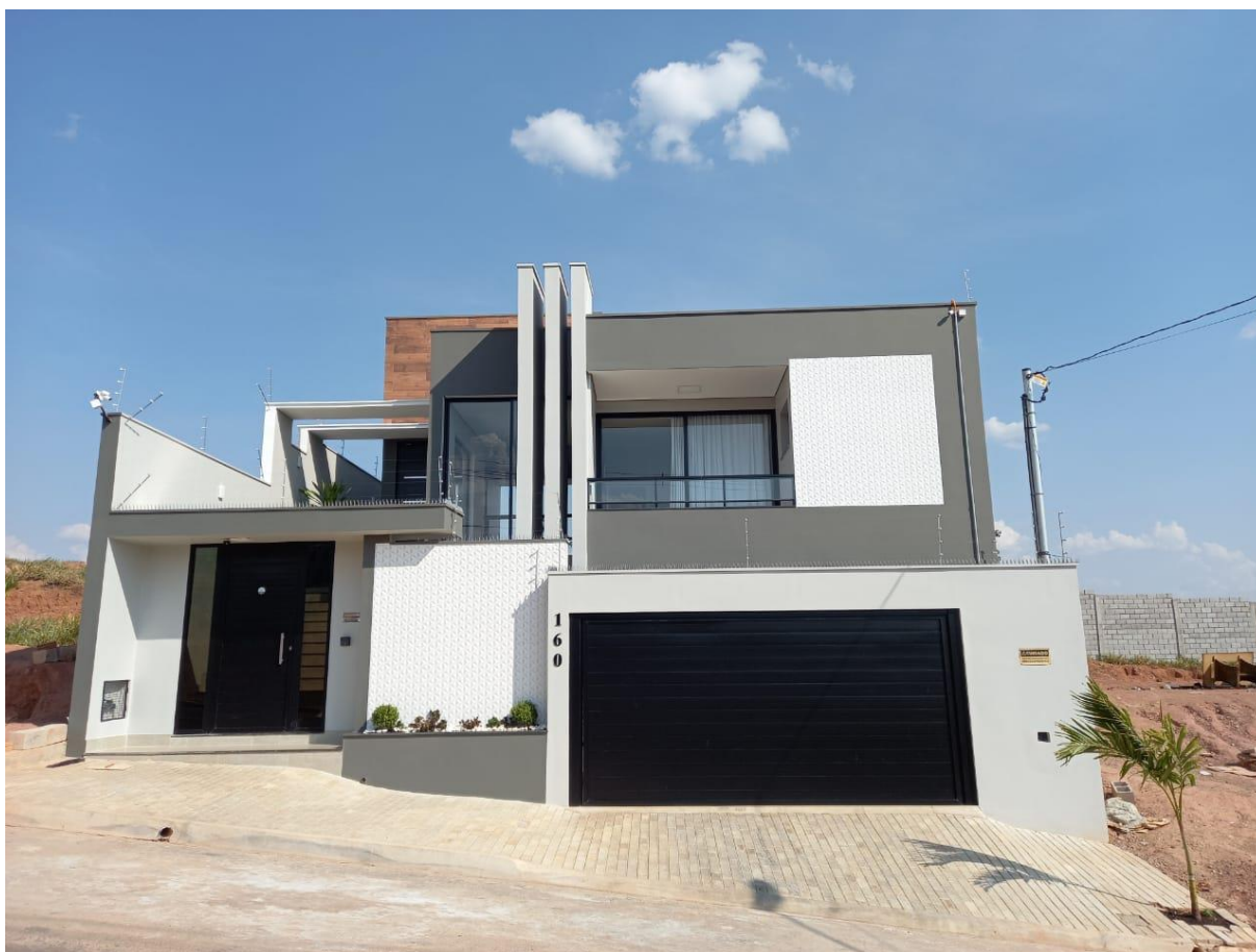
Figura 31: Obra finalizada – Varginha/MG.
