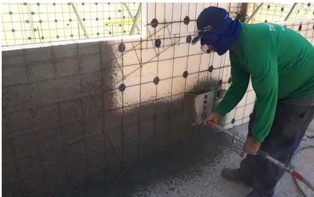
Figura 26: Aplicação de argamassa por equipamento de projeção – Varginha/MG.
