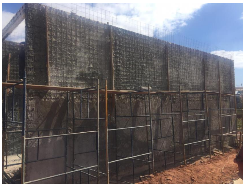
Figura 27: Revestimento das Paredes de EPS – Varginha/MG.
