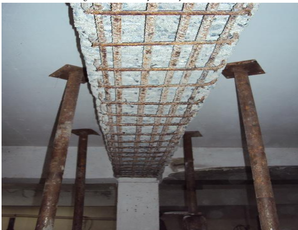
Figura 53: Modificação de seção.
