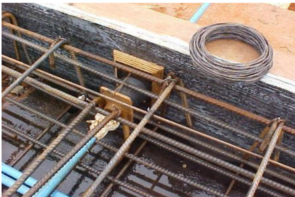
Figura 13: Detalhe da ancoragem ativa.
