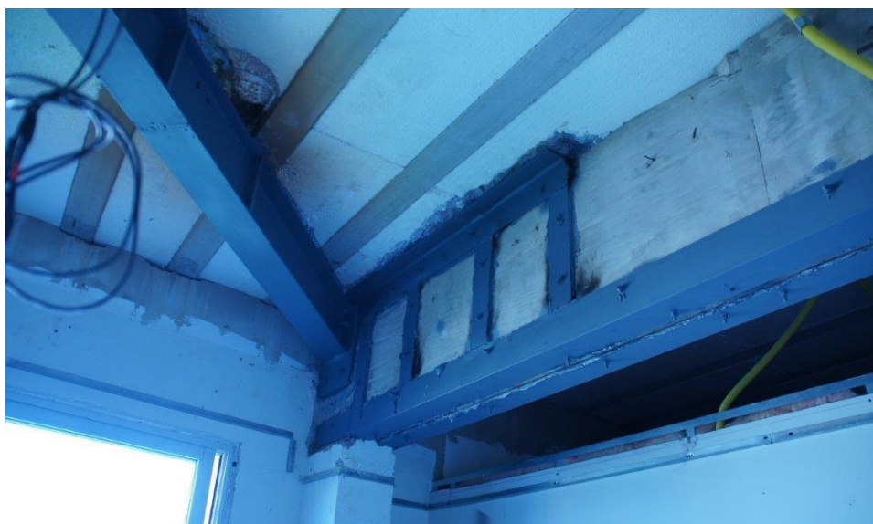
Figura 77: Reforço a Flexão com a utilização do perfil U metálico.
