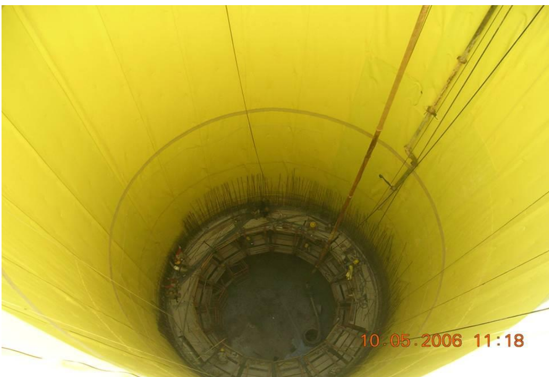
Figura 62: Recuperação da estrutura do Metrô com a utilização de Geomembrana de PVC, Libra 4 Amarela – SP
