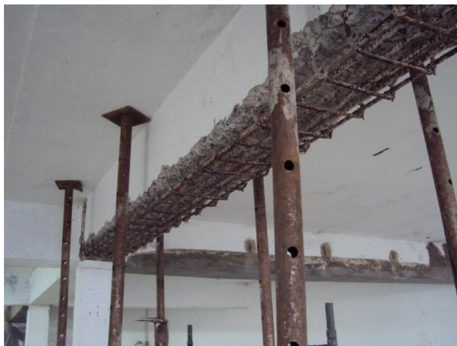
Figura 54: Modificação de seção.
