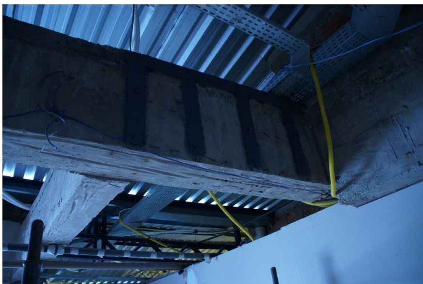
Figura 76: Reforço com a utilização de chapas metálicas.
