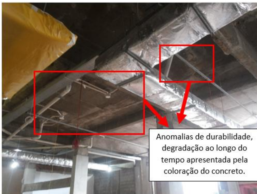
Figura 65: Demonstração das anomalias de durabilidade na estrutura.
