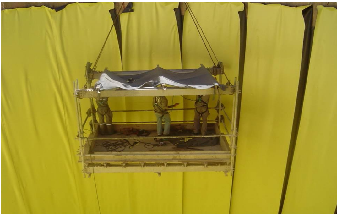
Figura 61: Recuperação da estrutura do Metrô com a utilização de Geomembrana de PVC, Libra 4 Amarela – SP.
