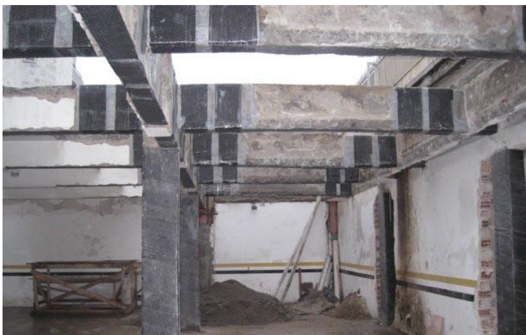
Figura 44: Reforço de vigas e pilares com fibra de carbono.
