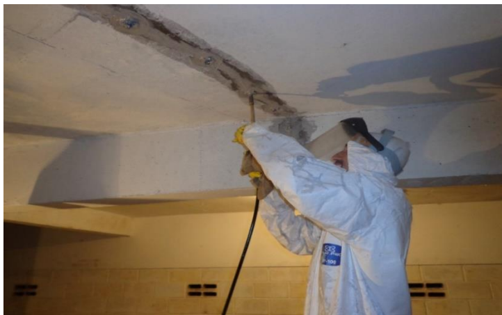
Figura 59: Aplicação de resina de poliuretano.
