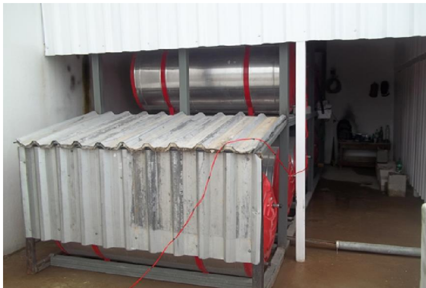
Figura 73: Reservatórios (boilers) que foram colocados no quinto andar.
