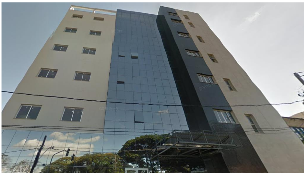
Figura 64: Foto da edificação localizada em Varginha/MG.
