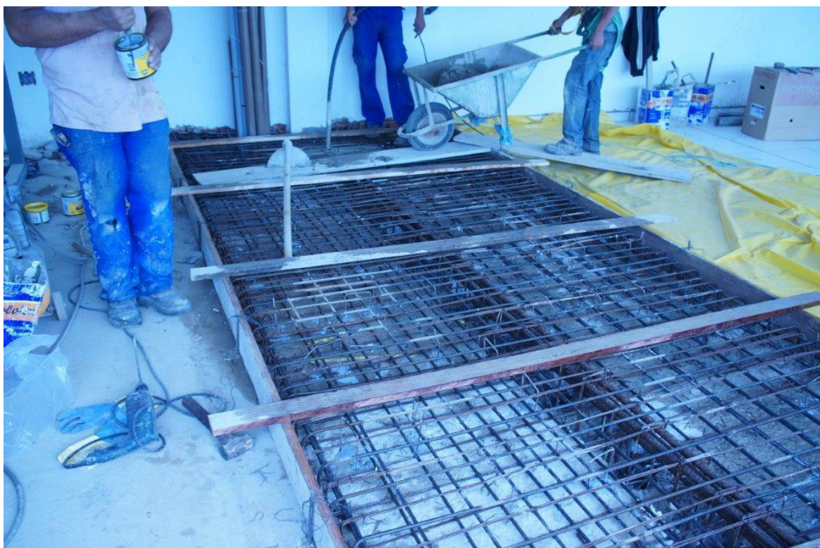
Figura 72: Aplicação do adesivo epóxi.
