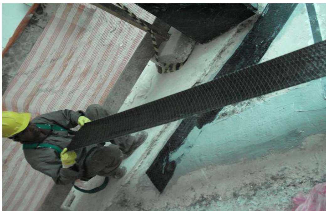
Figura 46: Reforço com Fibra de carbono – Parque Shopping Barueri –SP
