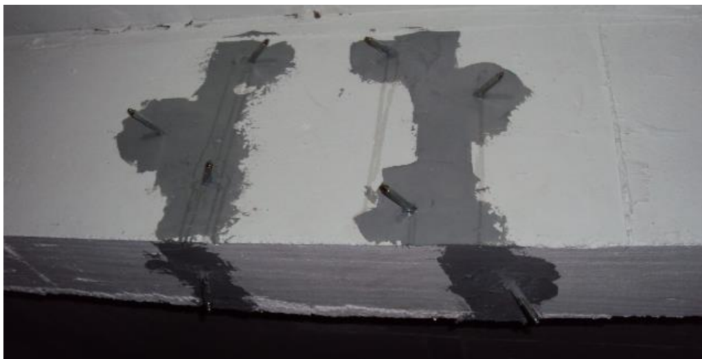
Figura 60: Aplicação da resina epóxi
