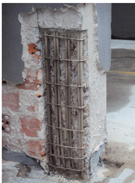
Figura 34: Armadura de complementação.
