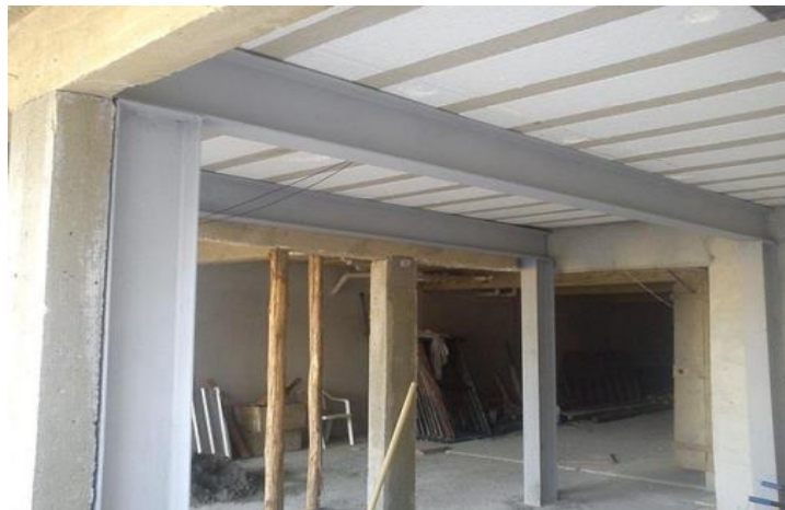
Figura 42: Reforço com perfis metálicos.
