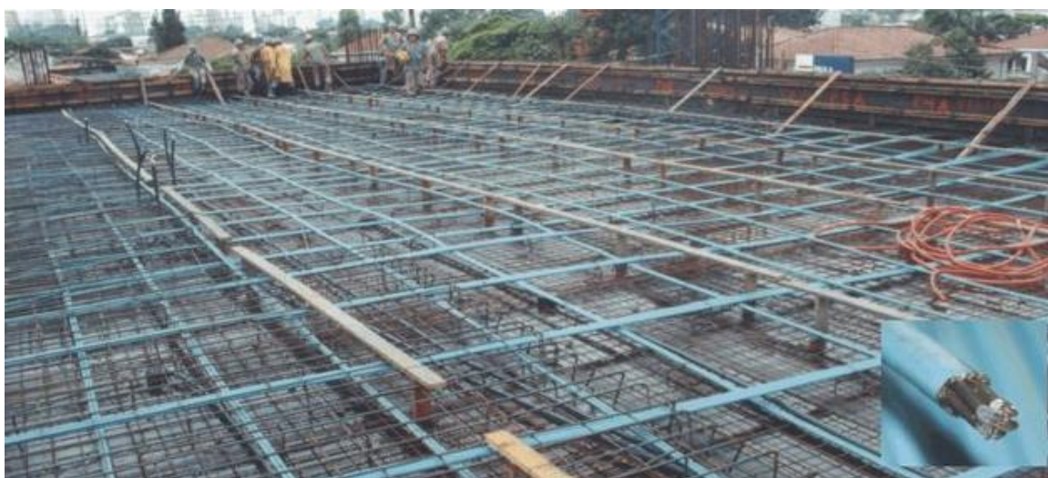
Figura 8: Laje plana protendida.
