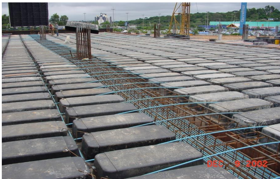
Figura 10: Laje nervurada com cubetas plásticas.
