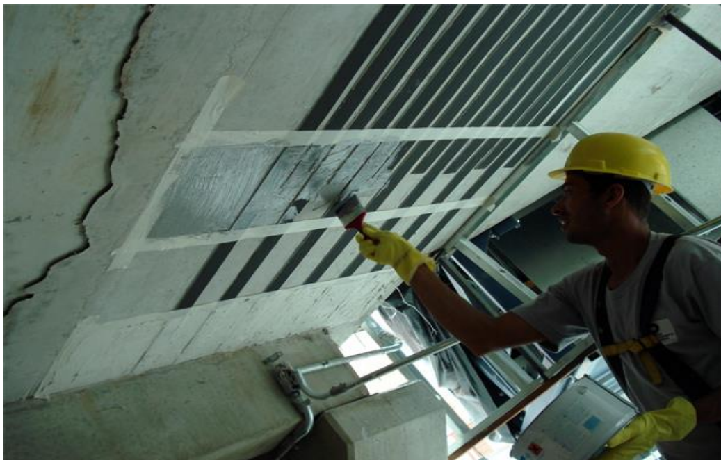
Figura 45: Reforço com Fibra de carbono – Parque Shopping Barueri –SP
