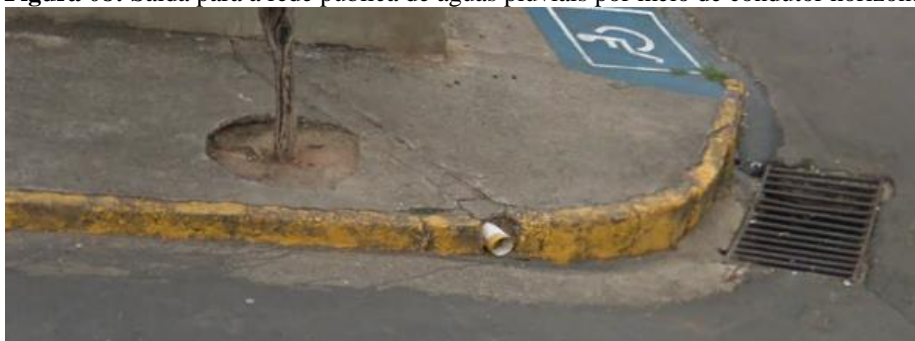
Figura 08: Saída para a rede pública de águas pluviais por meio de condutor horizontal.
