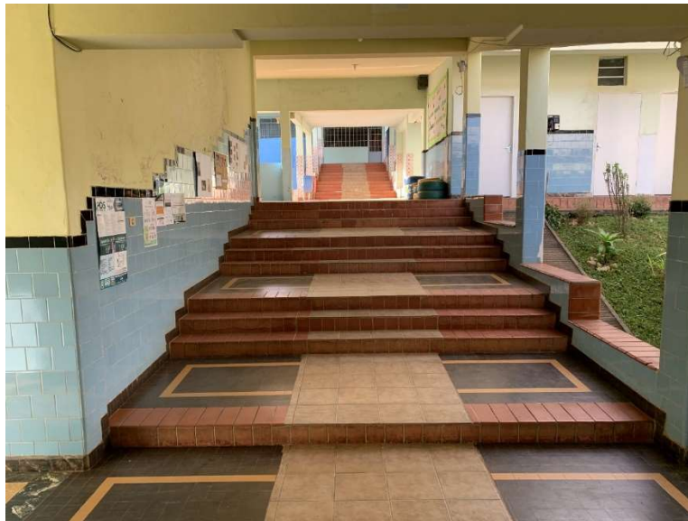
Figura 2. Escadas do bloco 01 (acima) e bloco 03 (abaixo).
