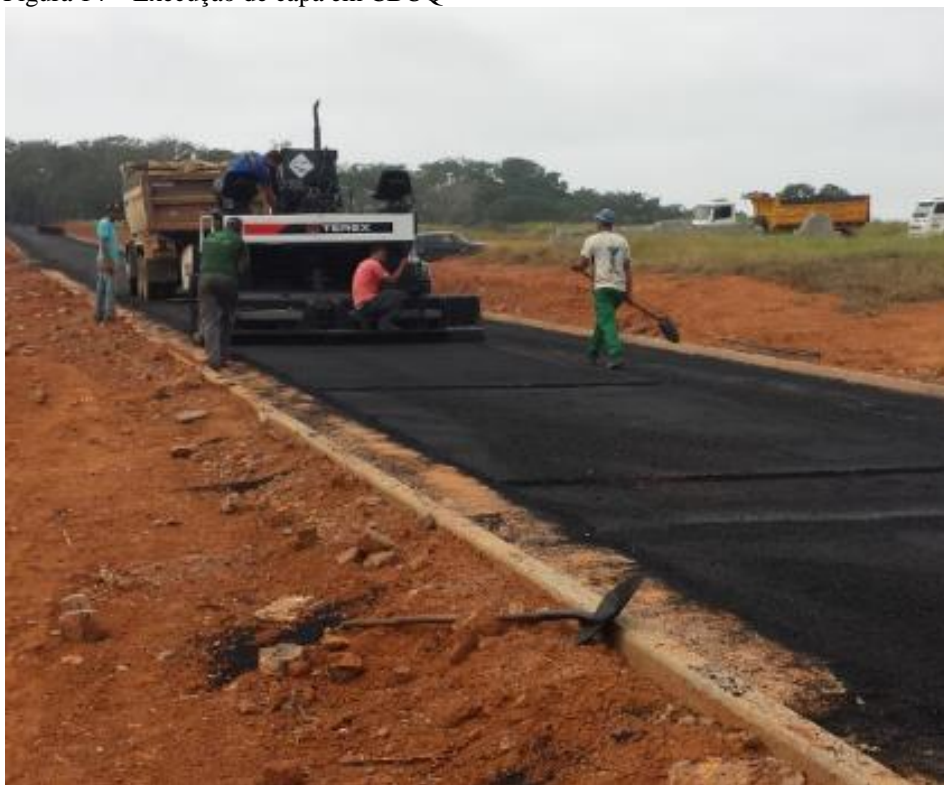
Figura 14 – Execução de capa em CBUQ
