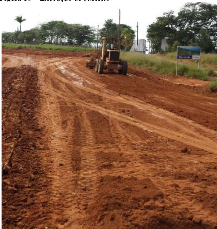
Figura 10 – Execução de subleito
