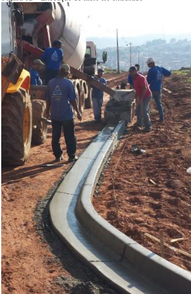
Figura 12 – Execução de meio fio extrusado
