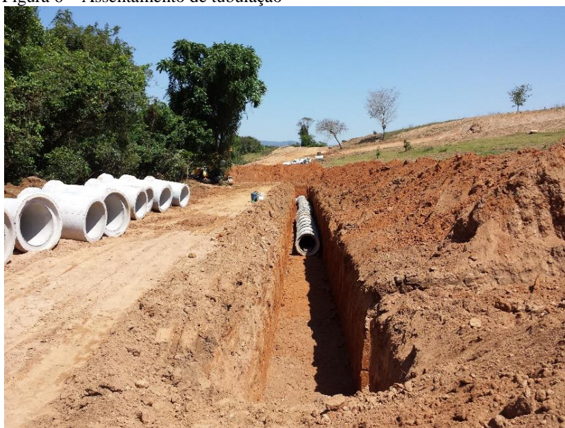
Figura 6 – Assentamento de tubulação
