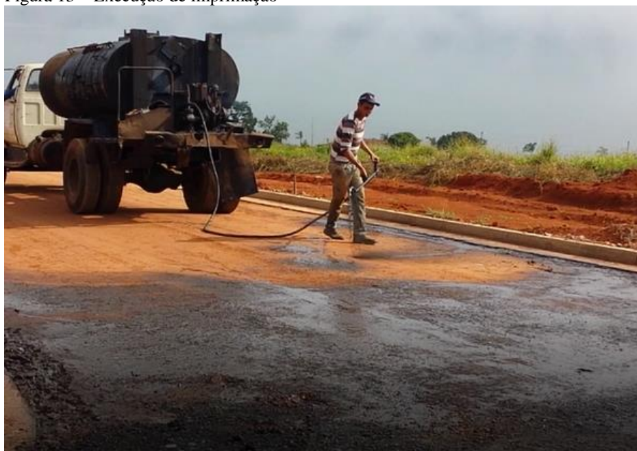
Figura 13 – Execução de imprimação
