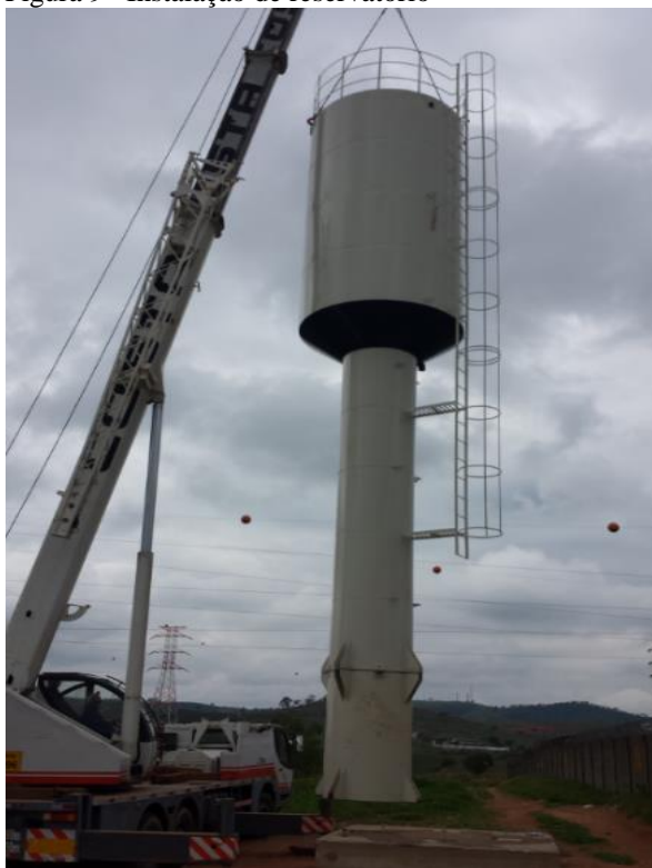
Figura 9– Instalação de reservatório
