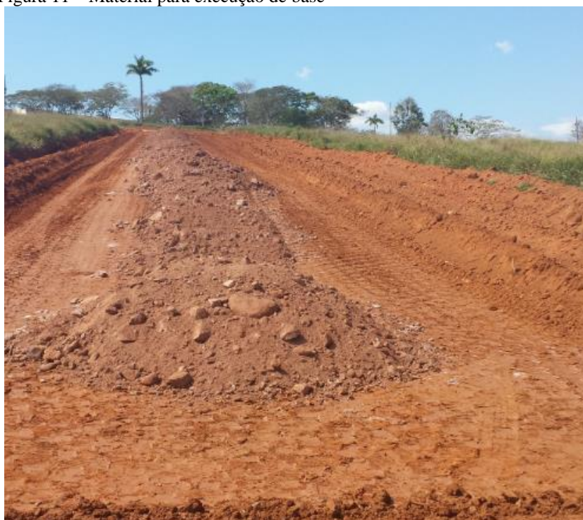
Figura 11 – Material para execução de base
