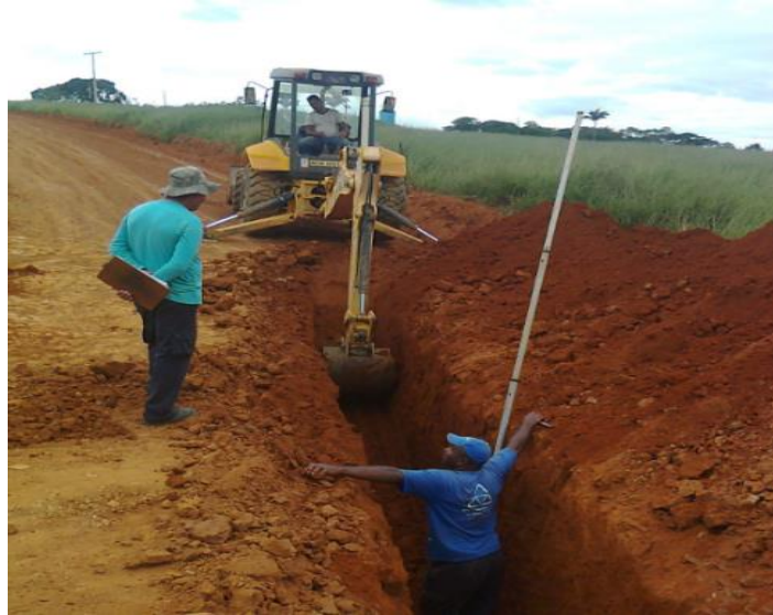
Figura 4 - Escavação de valas
