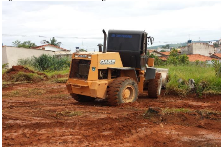
Figura 1-Retirada de matéria vegetal
