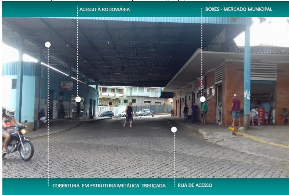
Figura 36 - Mercado Municipal de Paraguaçu, fachada e estruturas.
