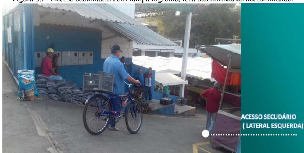
Figura 35 - Acesso secundário com rampa íngreme, fora das normas de acessibilidade.
