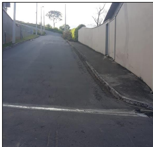
Figura 2: Rua dos Curimatás
