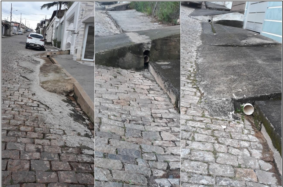
Figura 5: Rampas de garagem.
