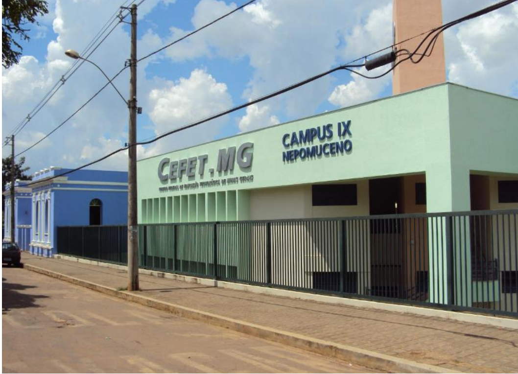
Figura 5: Fachada da instituição.
