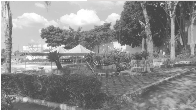
[47]: área de descanso com bancos quebrados
