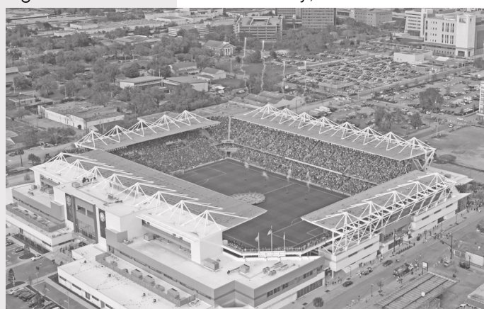
Figura 20 - Estádio do Orlando City, EUA
