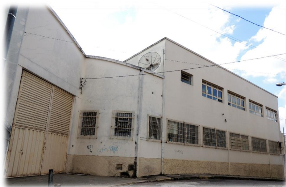
Figura 52-Calçada da fachada sul
