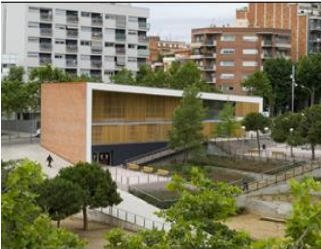
Figura 19- Fachada Casa para Terceira Idade
