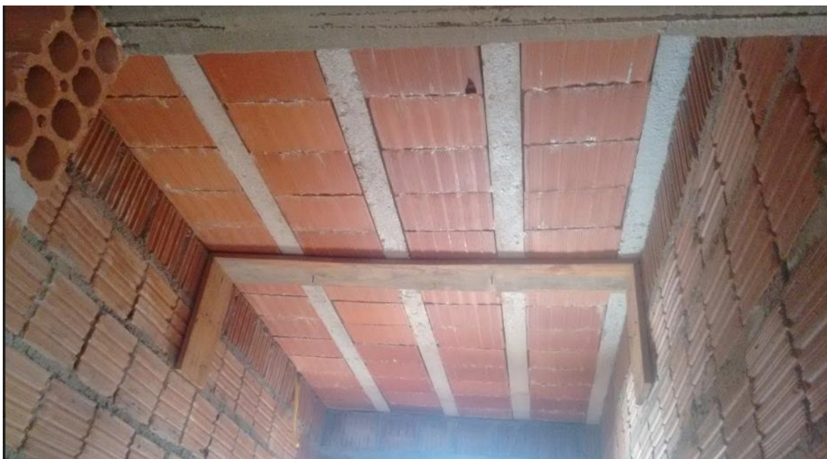
Figura 20 – Imagem da laje do banheiro
