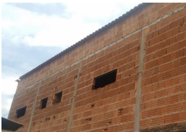
Figura 25 – imagem lateral das aberturas feitas para a instalação das janelas
