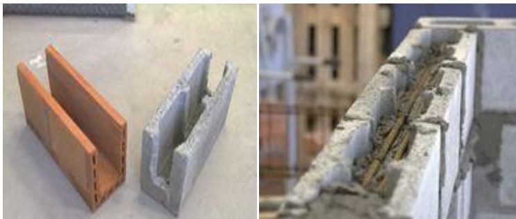
Figura 11 – bloco canaleta utilizado para fabricação de verga in loco
