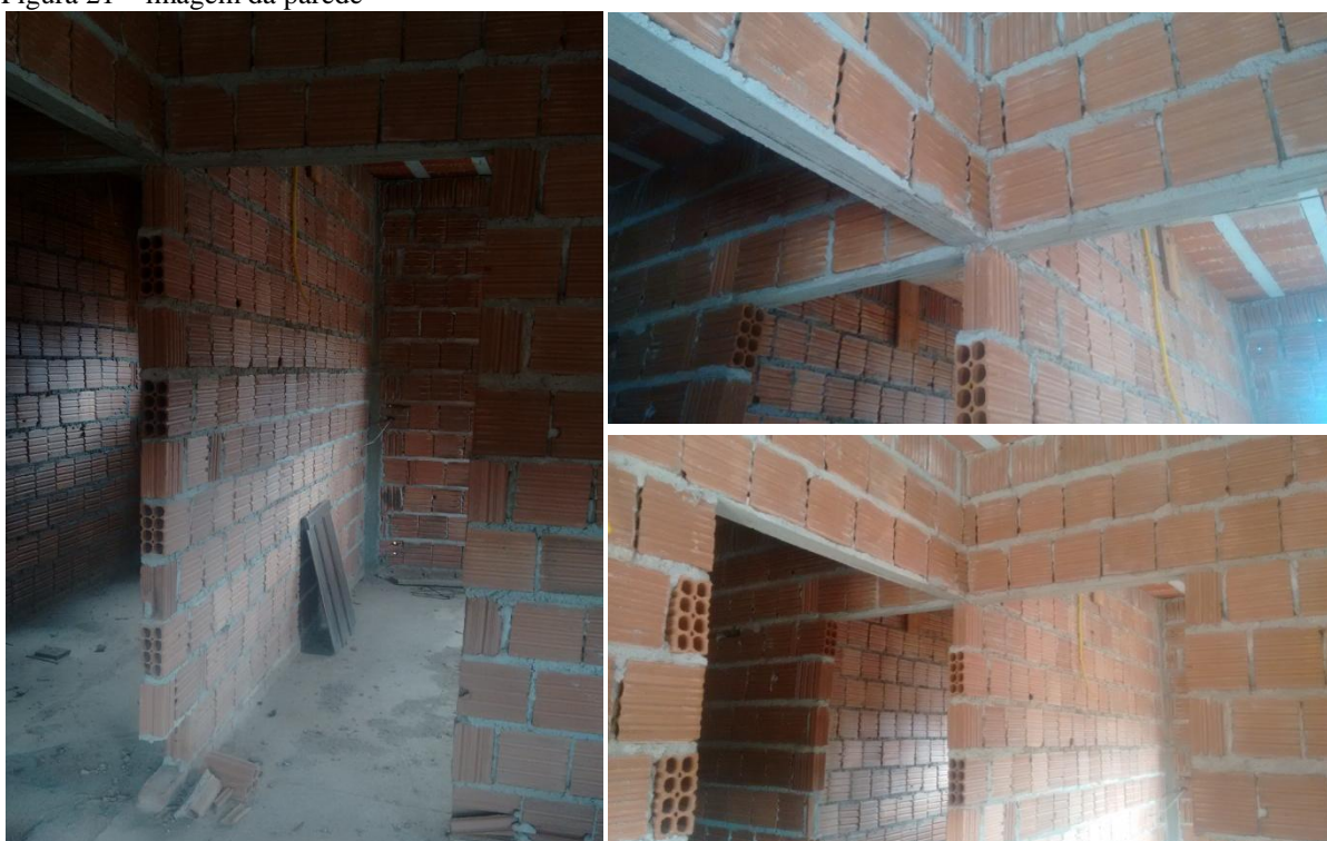
Figura 21 – imagem da parede
