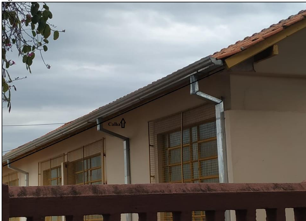
Figura 8 – Calhas localizadas no bloco 1.
