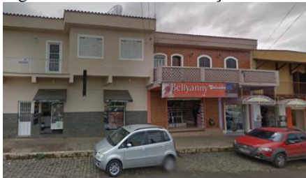
Figura 17 - Vista das edificações mistas
