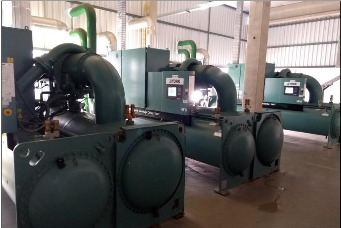
Figura 23 - Instalação de chillers.
