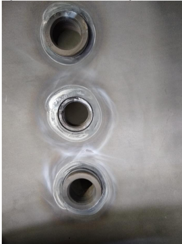
Figura 20 – Vista interna da calota da figura 19
