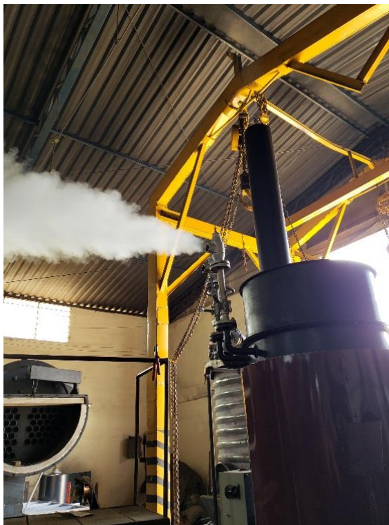
Figura 14: Acionamento da válvula de segurança
