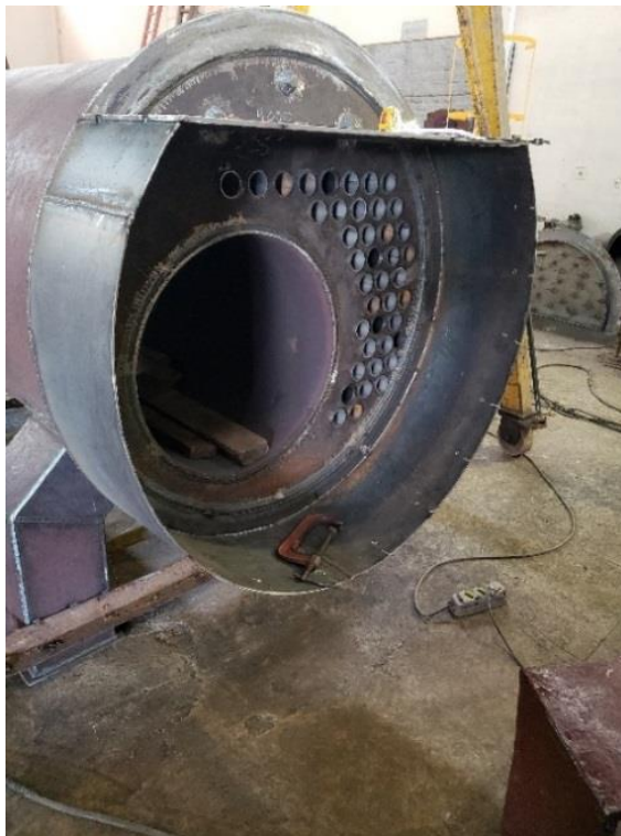
Figura 10: instalação dos tubos
