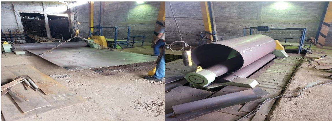
Figura 07: Processo de calandragem da chapa
