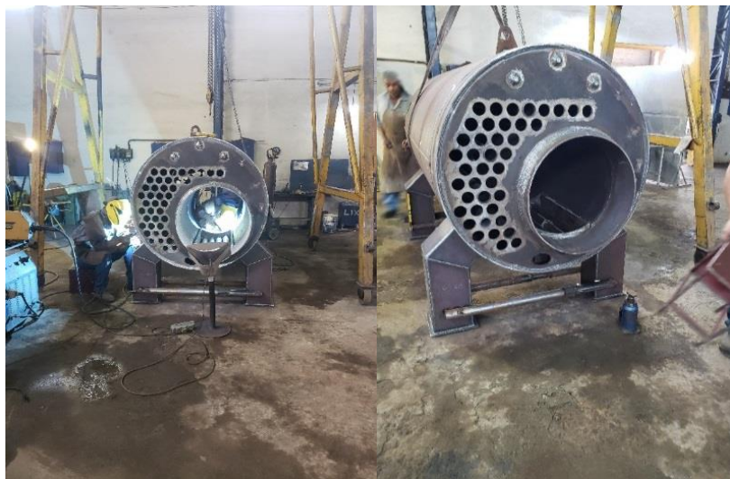
Figura 09: soldagens das peças instaladas
