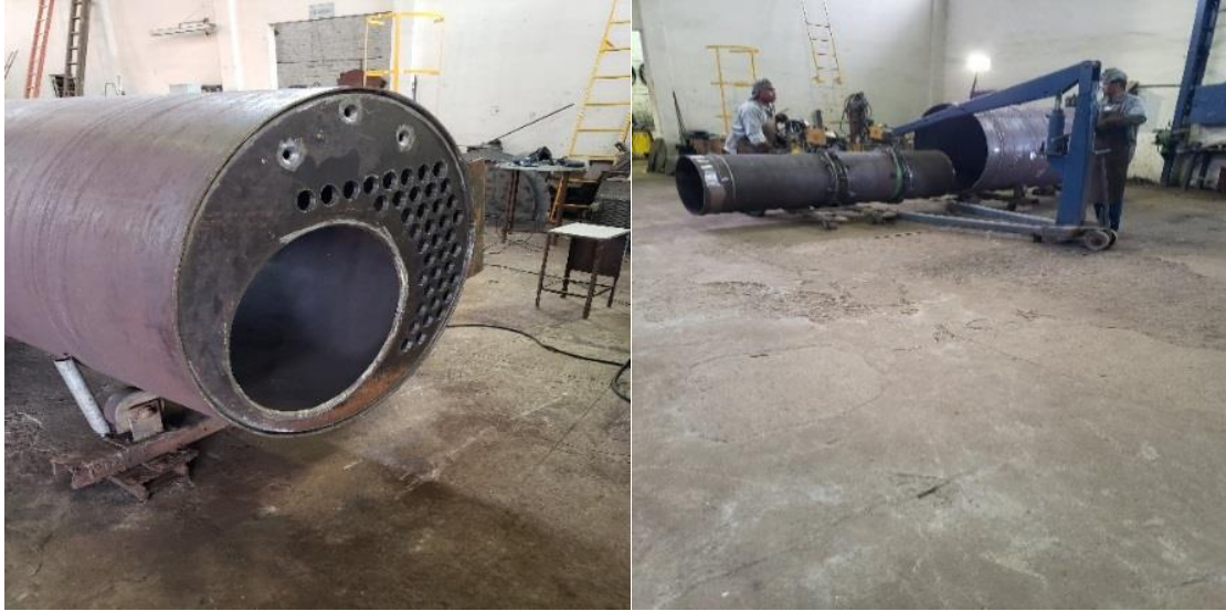
Figura 08: Instalação da fornalha e espelho
