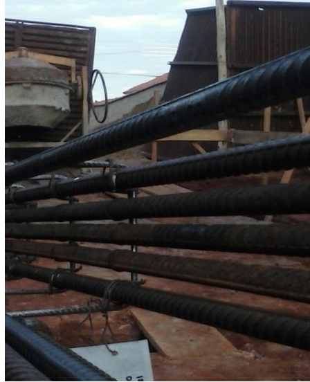
Figura 4.8: Detalhe pilar P10 térreo.
