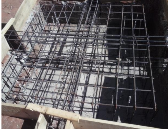
Figura 4.3: Fundação pilar P11.
