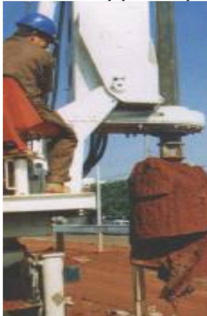
Figura 2.6: Detalhe do equipamento de perfuração.
