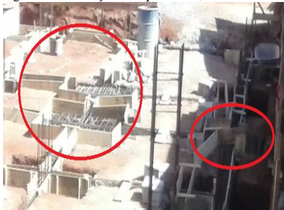
Figura 4.4: Fundações dos pilares P7, P11 e P12.
