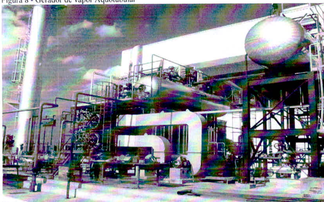
Figura 8 - Gerador de vapor Aquotubular
