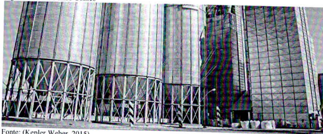
Figura 6 - Silos Fundo Cônico
