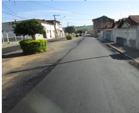
Figura 5- Execução de recapeamento asfáltico
