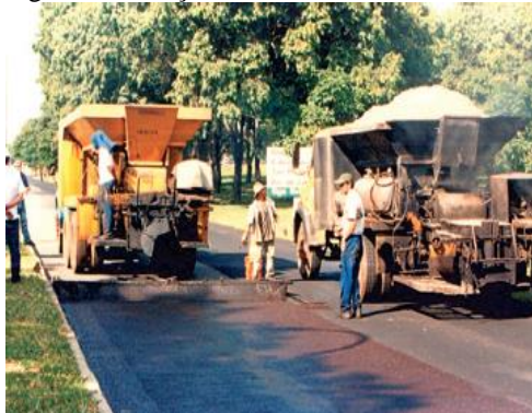
Figura 7-Execução da lama asfáltica
