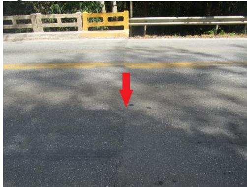
Figura 21- Trincas Transversais
