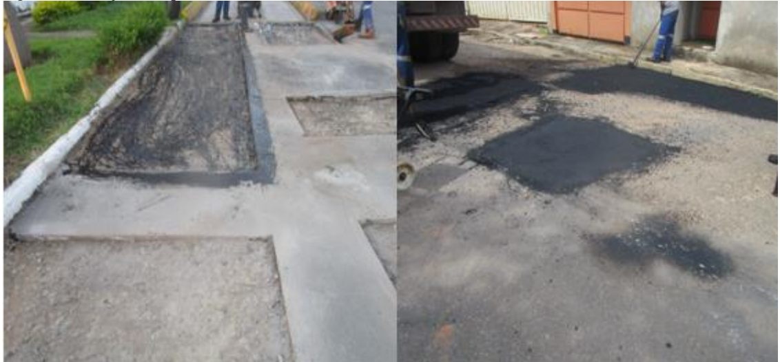
Figura 3-Execução de tapa buraco
