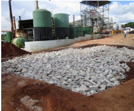
Figura 4-Execução de Remendo Profundo
