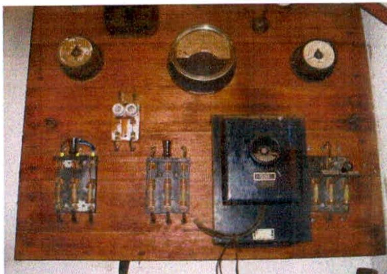
*Foto 12: Exemplo de Painel de controle de micro central hidrelétrica*
