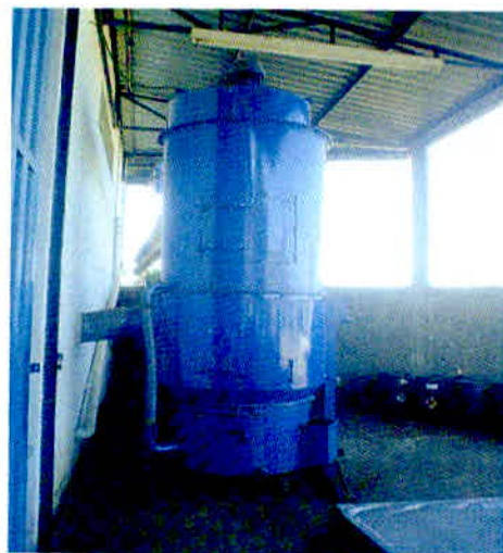
Figura 09. Sistema de exaustão Ciclônico (Fonte: o autor)
