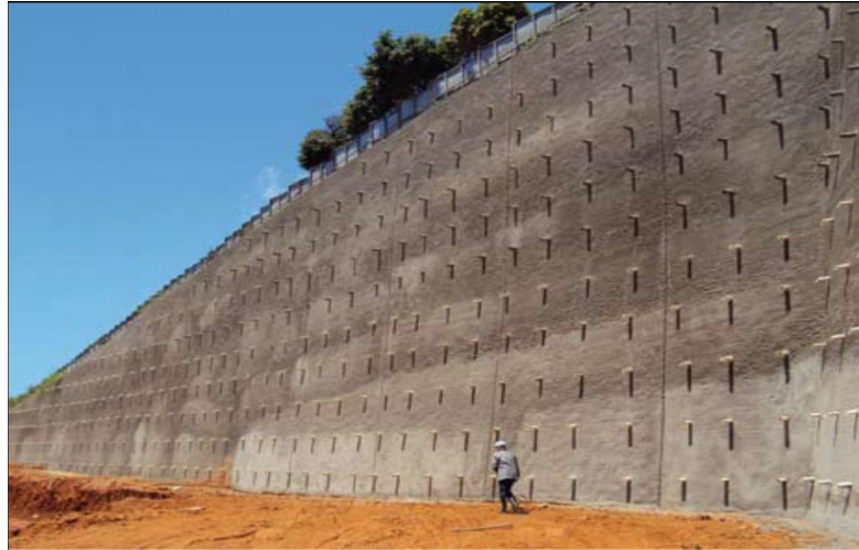
Figura 2.4: Obra de contenção em solo grampeado
