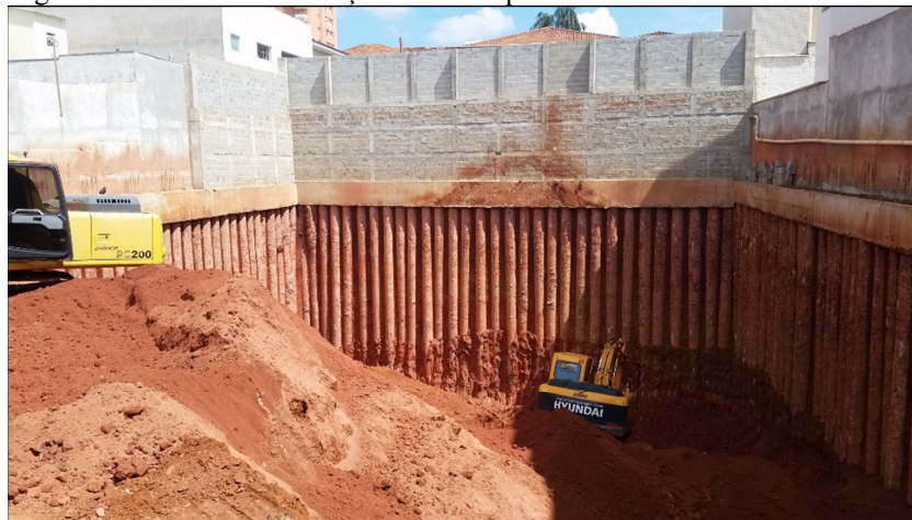
Figura 4.1: Início das escavações com máquinas
