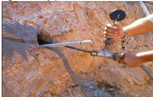
Figura 2.13: Injeção da calda de cimento
