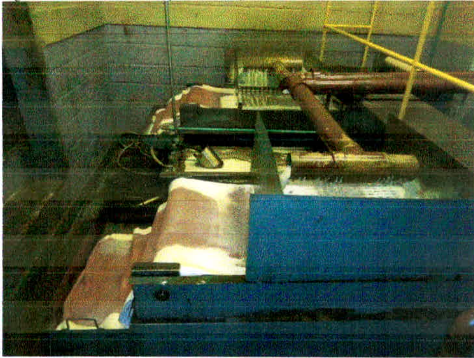
Figura 14: Central de lubrificação de trefilação.
