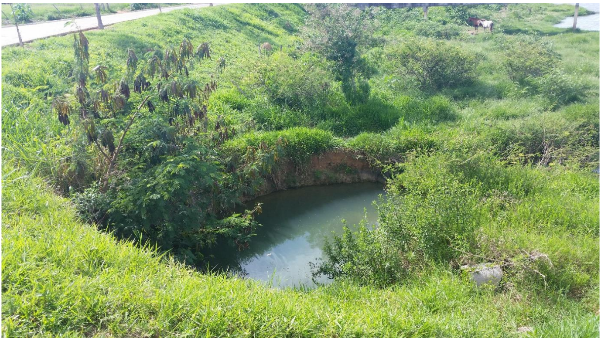
Figura 25 – Local onde deságuam as 03 galerias já instaladas.
