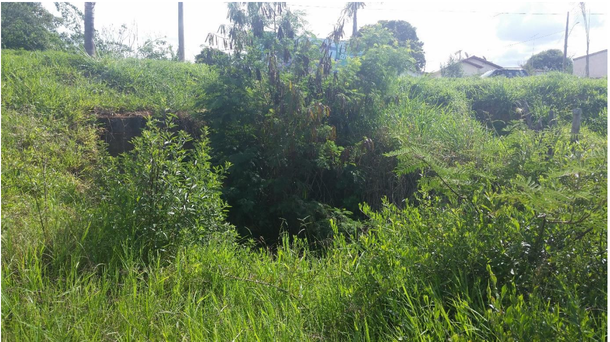
Figura 40 – Local de deságue das galerias no lago.
