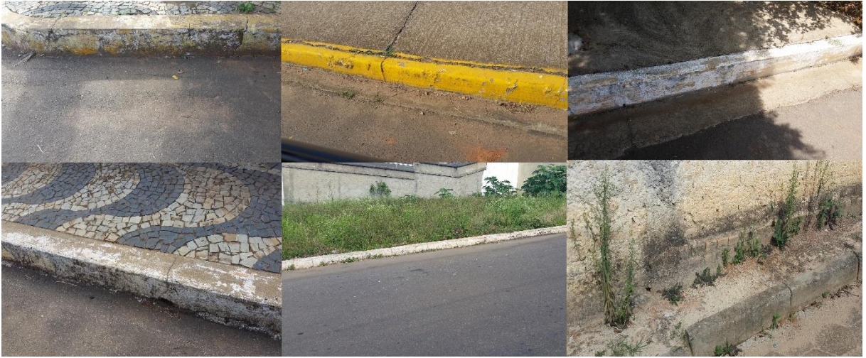
Figura 39 – Sarjetas de outros trechos da bacia.
