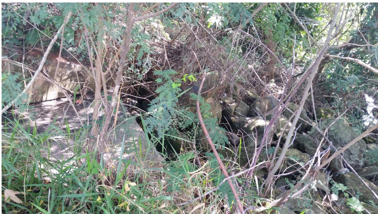
Figura 23 – Local onde deságuam as galerias.
