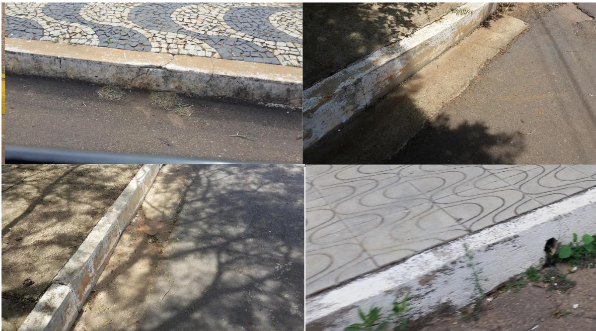
Figura 31 – Situação das sarjetas.
