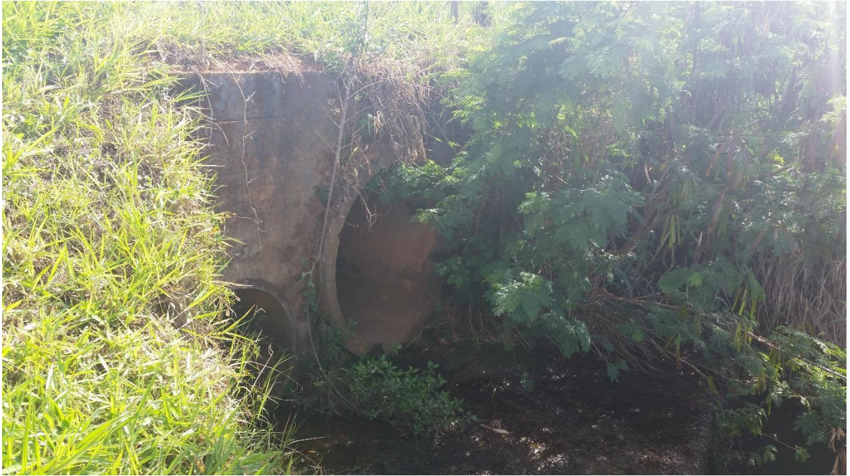
Figura 24 – Galerias pluviais já instaladas.
