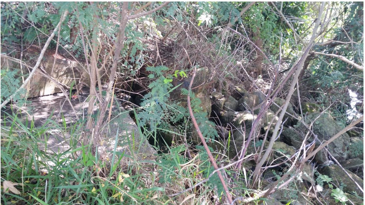
Figura 38 – Local onde deságuam as galerias.
