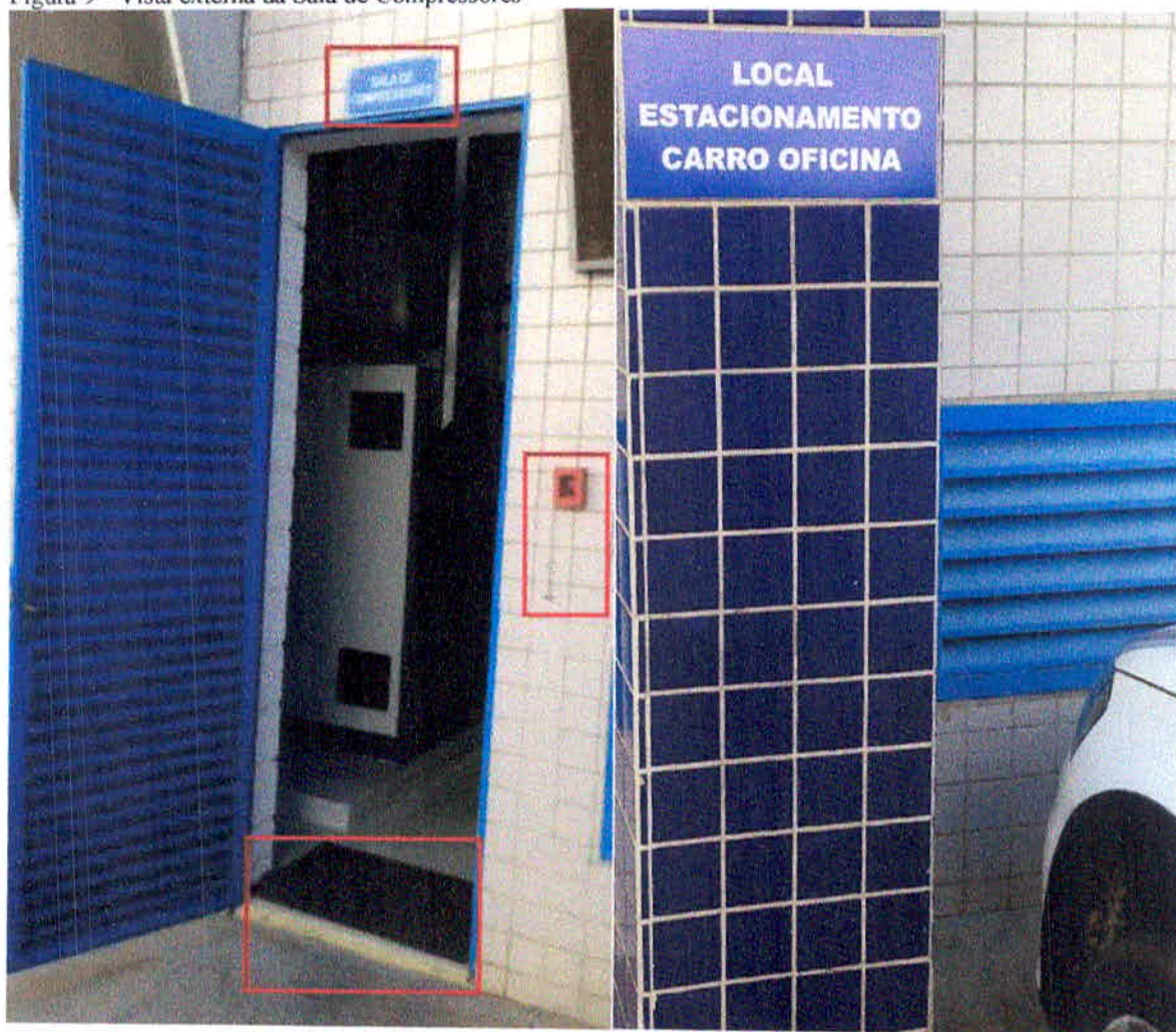
Figura 9 - Vista externa da Sala de Compressores
