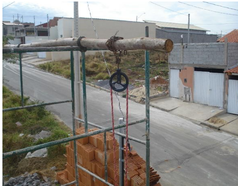
Figura 09- Carretilha manual para transporte vertical de materiais
