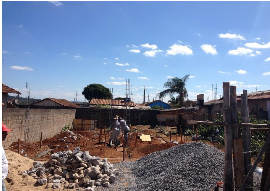
Figura 16- Canteiro de obra.
