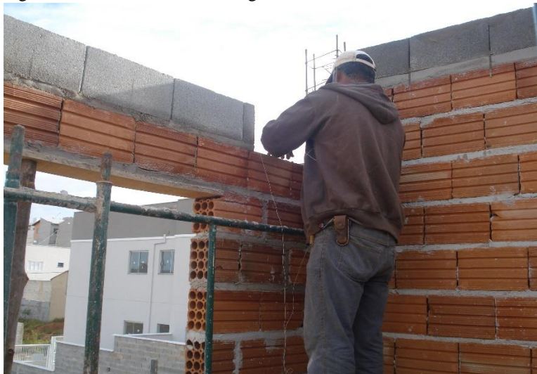
Figura 12: Assentamento com argamassa mista
