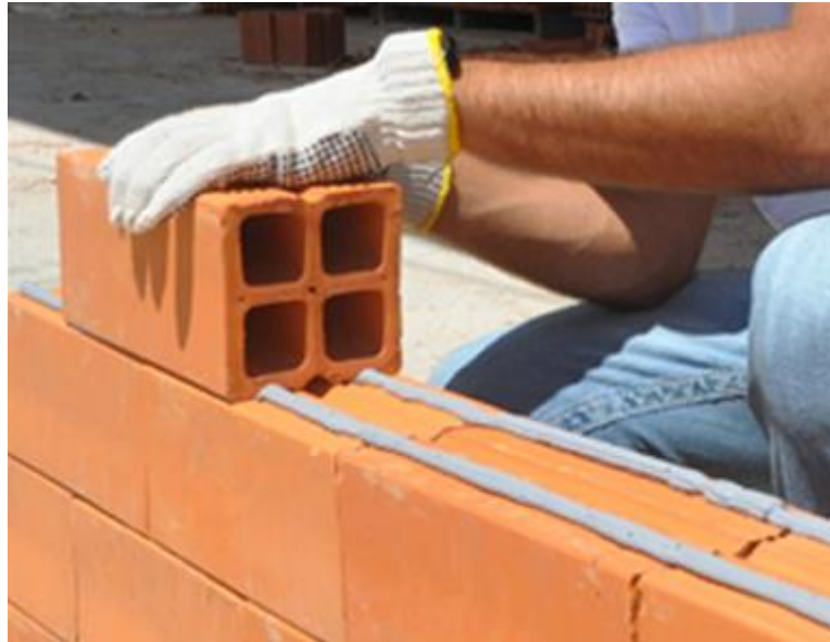
Figura 11- Assentamento com argamassa polimérica
