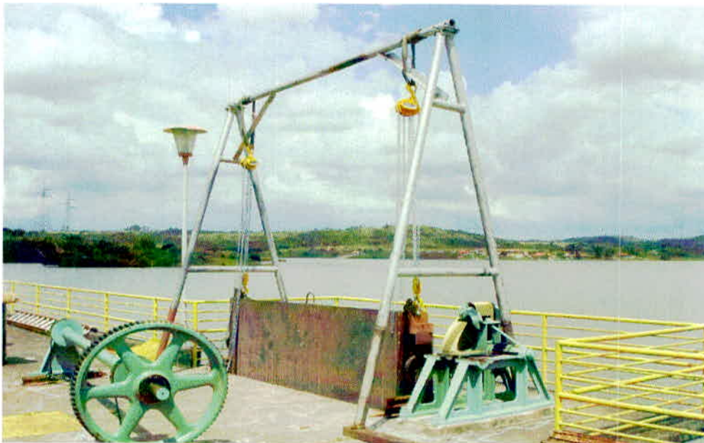
Figura 10: A Comporta de Limpeza sendo Içada para Manutenção – Vista Geral Fonte: Autor
