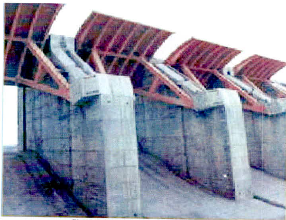
Figura 7: Exemplo de Comporta Segmento Fonte: Autor
