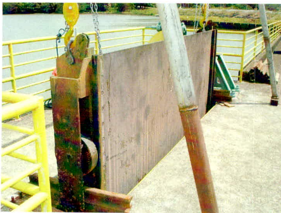
Figura 9: A Comporta de Limpeza sendo içada para Manutenção Fonte: Autor
