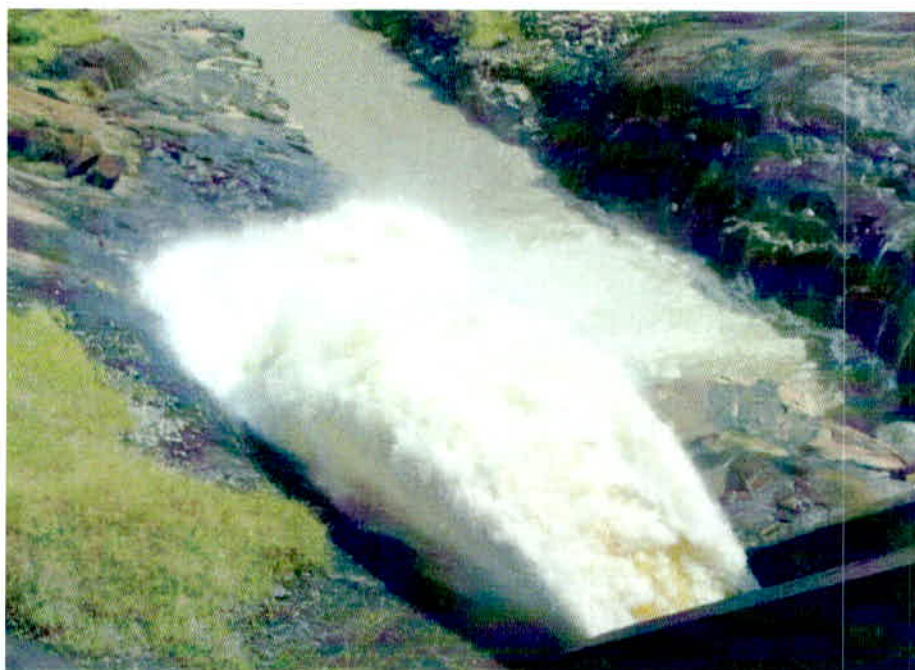
Figura 27 – Água Vertida da Comporta de Limpeza
