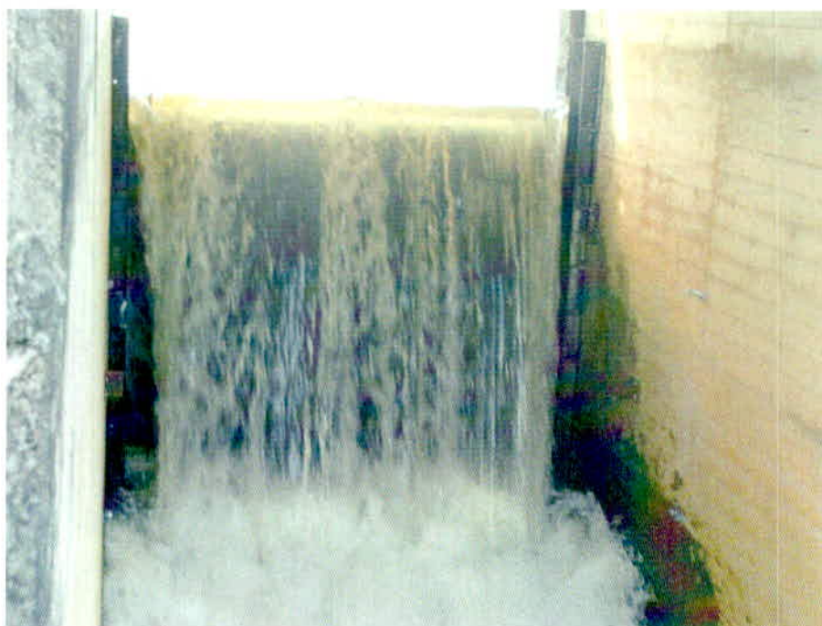
Figura 25 – Abertura Parcial da Comporta de Limpeza Fonte: Autor
