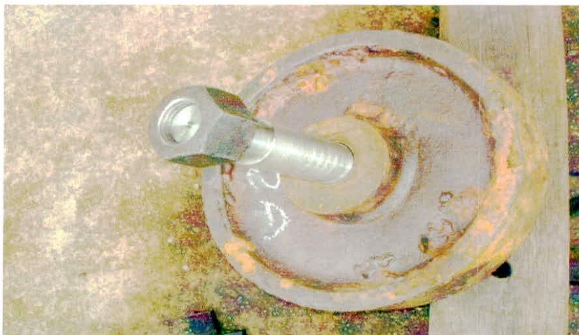
Figura 15: Roda da Comporta de Limpeza Fonte: Autor
