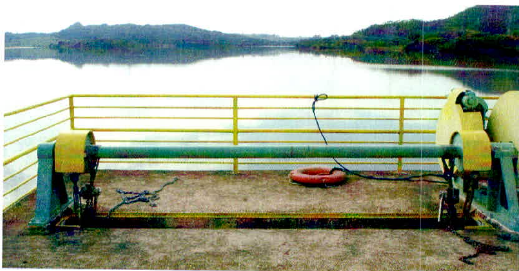
Figura 12: Mecanismo de Manobras da Comporta de Limpeza Fonte: Autor
