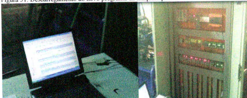
Figura 31: Descarregamento do novo programa da máquina para o PLC.
